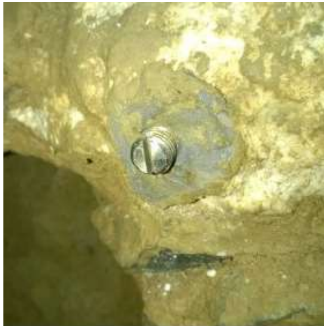
Obr. 3.3 - Ukázka stabilizace bodu měřické sítě [15]
