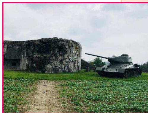
Obr. U89: Tank a bunkr v areálu opevnění
