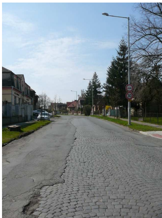
Obr. 6 - Pohled do Ořešské ulice severně od křižovatky s ulicí Eichlerovou
