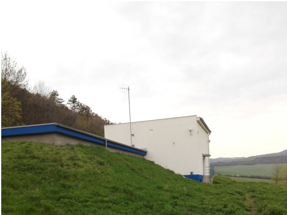
Obr. 2.2.4 – Vodojem Mostka IV
