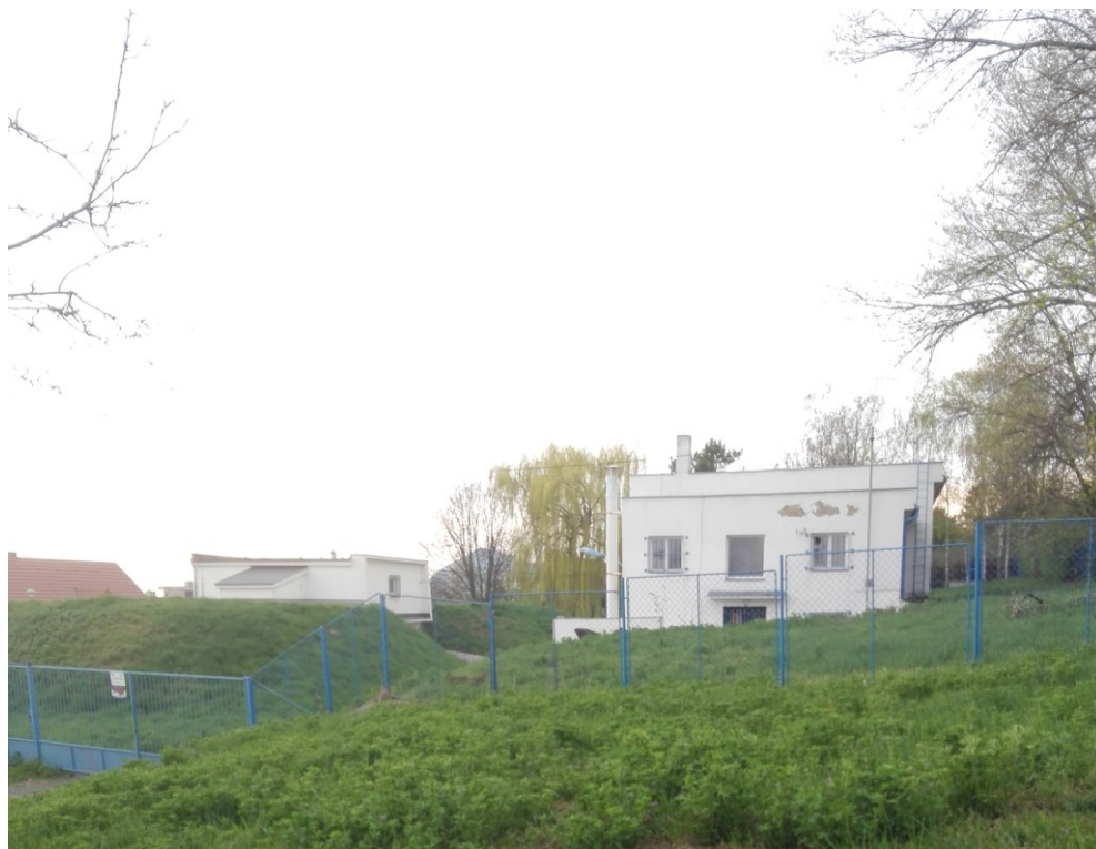
Obr. 2.2.1 – Vodojem Mostka III
