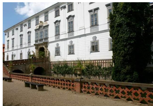
Obr. 45 - zábradlí u zámku Lysice ( http://www.images.atlasceska.cz/images/kalendarakci/velka/36280/v131121_zamek-lysice-2.jpg )
