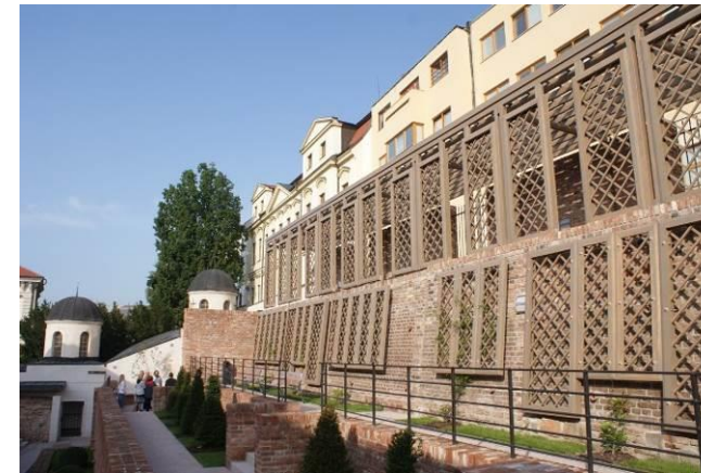
Obr. 40 - treláž podél zdi, Jižní terasy v Hradci Králové ( http://stavbaweb.dumabyt.cz/jizni-terasy-v-hradci-kralove-6730/clanek.html )
