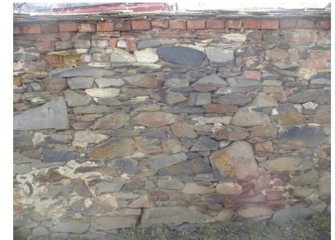
Obr. 2 - detail nepravidelného vzoru zdění z lomového kamene, droby, Předhradí
