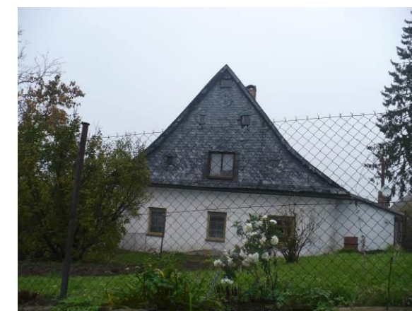
Obr. 52 - plot z drátěného pletiva, Červená Voda
