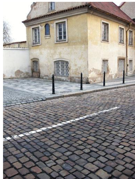
Obr. 19 - kočíí dlažba, křemenec, Praha ( http://departments.fsv.cvut.cz/k135/wwwold/webkurzy/PRAHA.data/Components/prazska_dlazba.html )
