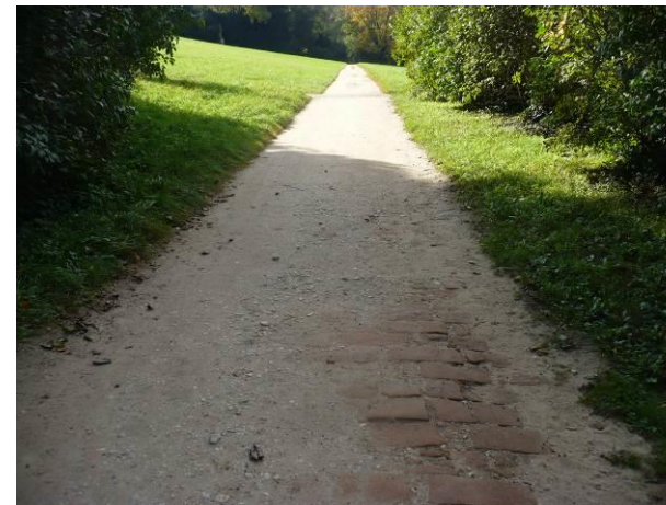
Obr. 46 - cihelná dlažba, Valtice
