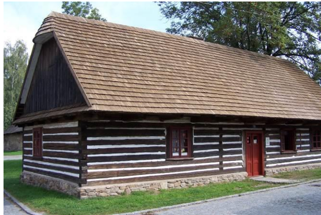
Obr. 34 - šindelová krytina, Betlém - Hlinsko
