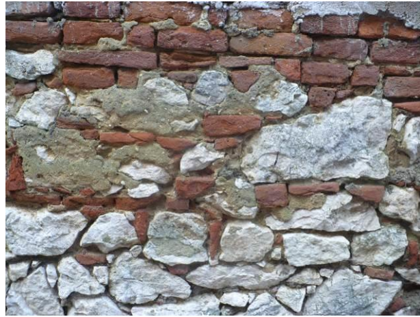
Obr. 7 - kombinované zdivo, vápenec a cihly, Mikulov
