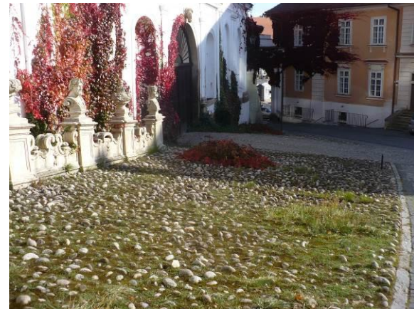
Obr. 18 - dlažba z valounů u zámku, vápenec, Mikulov
