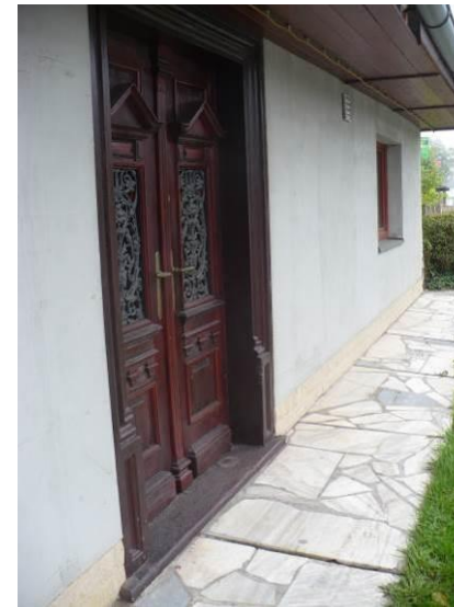
Obr. 11 - dlažební desky, mramor, Červená Voda
