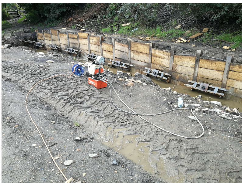
Obrázek č. 10: Napínání lanových kotev
