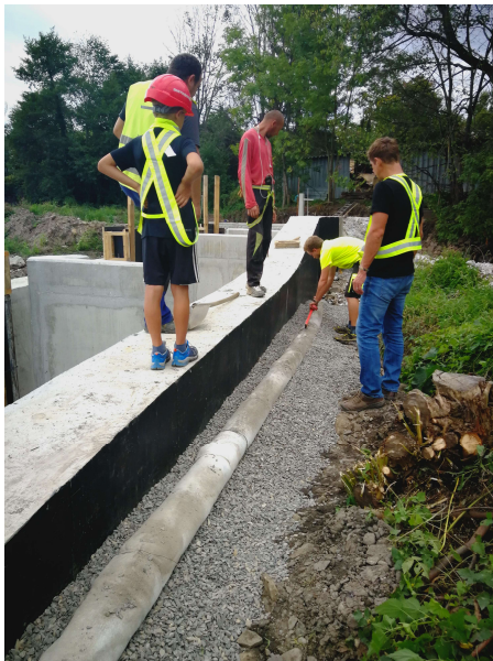
Obrázek č. 13: Drenážní potrubí HDPE DN 150
