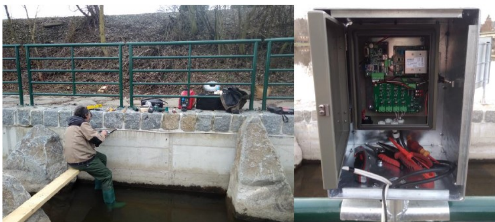
Obrázek č. 22: Instalace sledovacího zařízení
