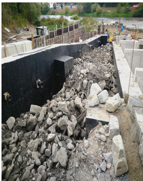
Obrázek č. 14: Příčné horizontální drény HDPE DN 100
