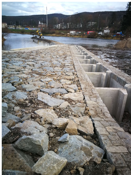
Obrázek č. 15: Ostrov vyplněný kamennou rovnáninou
