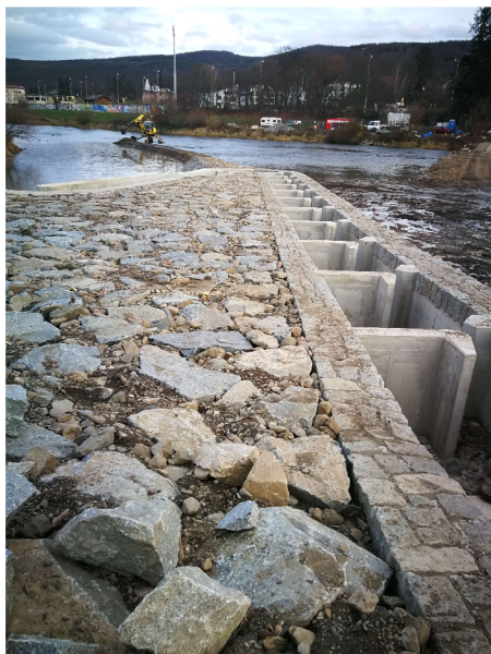
Obrázek č. 15: Ostrov vyplněný kamennou rovnatinou
