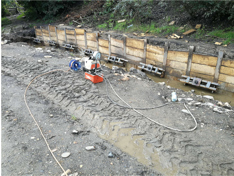
Obrázek č. 10: Napínání lanových kotev
