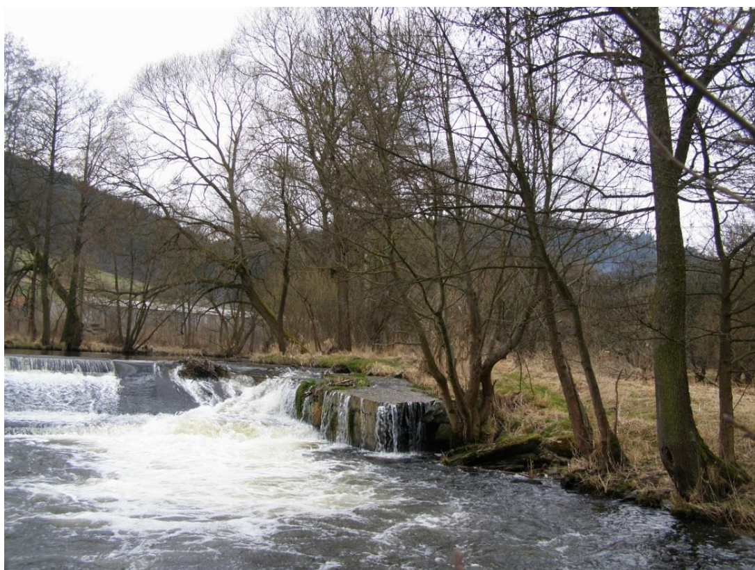
Fotografie 14: Pevný jez, poškozené levé betonové křídlo (foto František Bureš, 2/2015)
