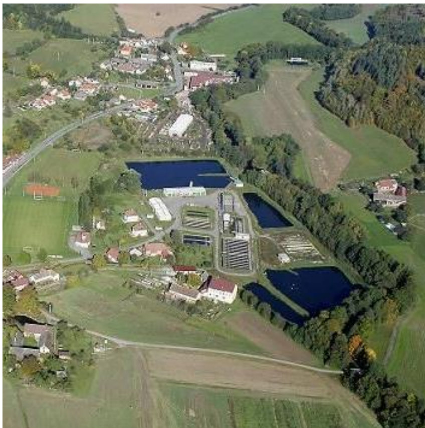
Obrázek 4 Letecký pohled na Ujčov s areálem rybářství a budovou bývalého mlýnu - rok 2010 (Štarha, 2010)
