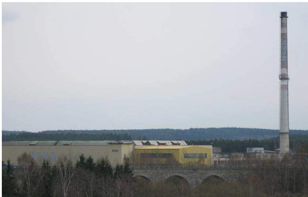
Obr. 3 Areál podniku ZVVZ a. s. na východ od města Milevsko
