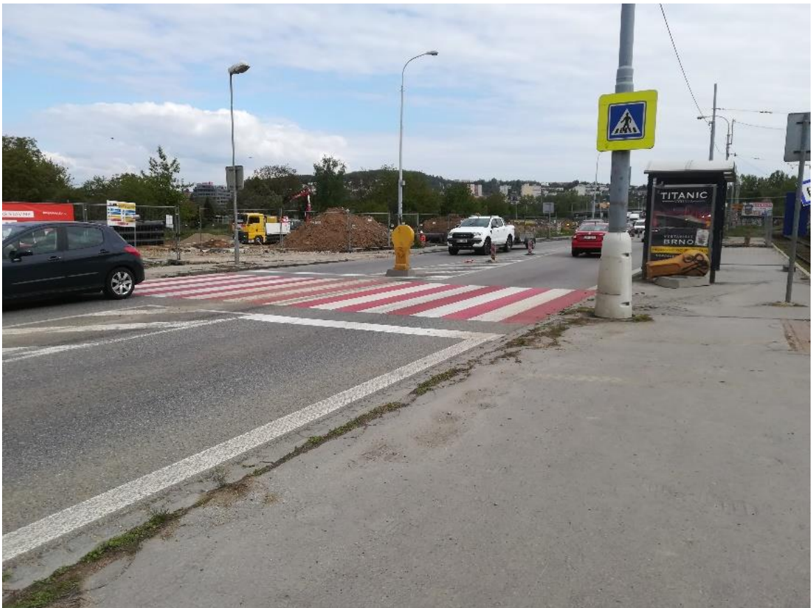
Obr. 57 – Přechod pro chodce na ulici Žabovřeská
