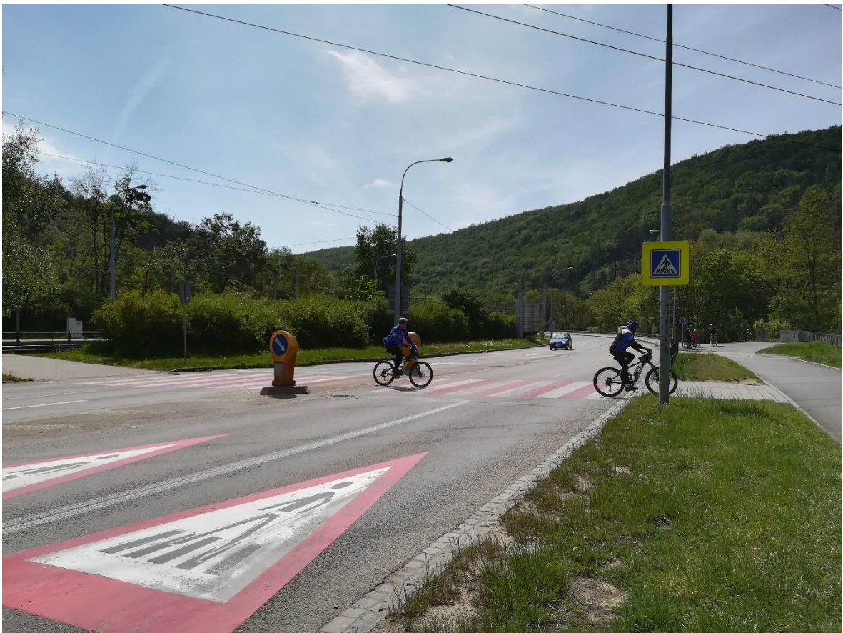
Obr. 30 – Přejchod pro chodce na ulici Kníničská
