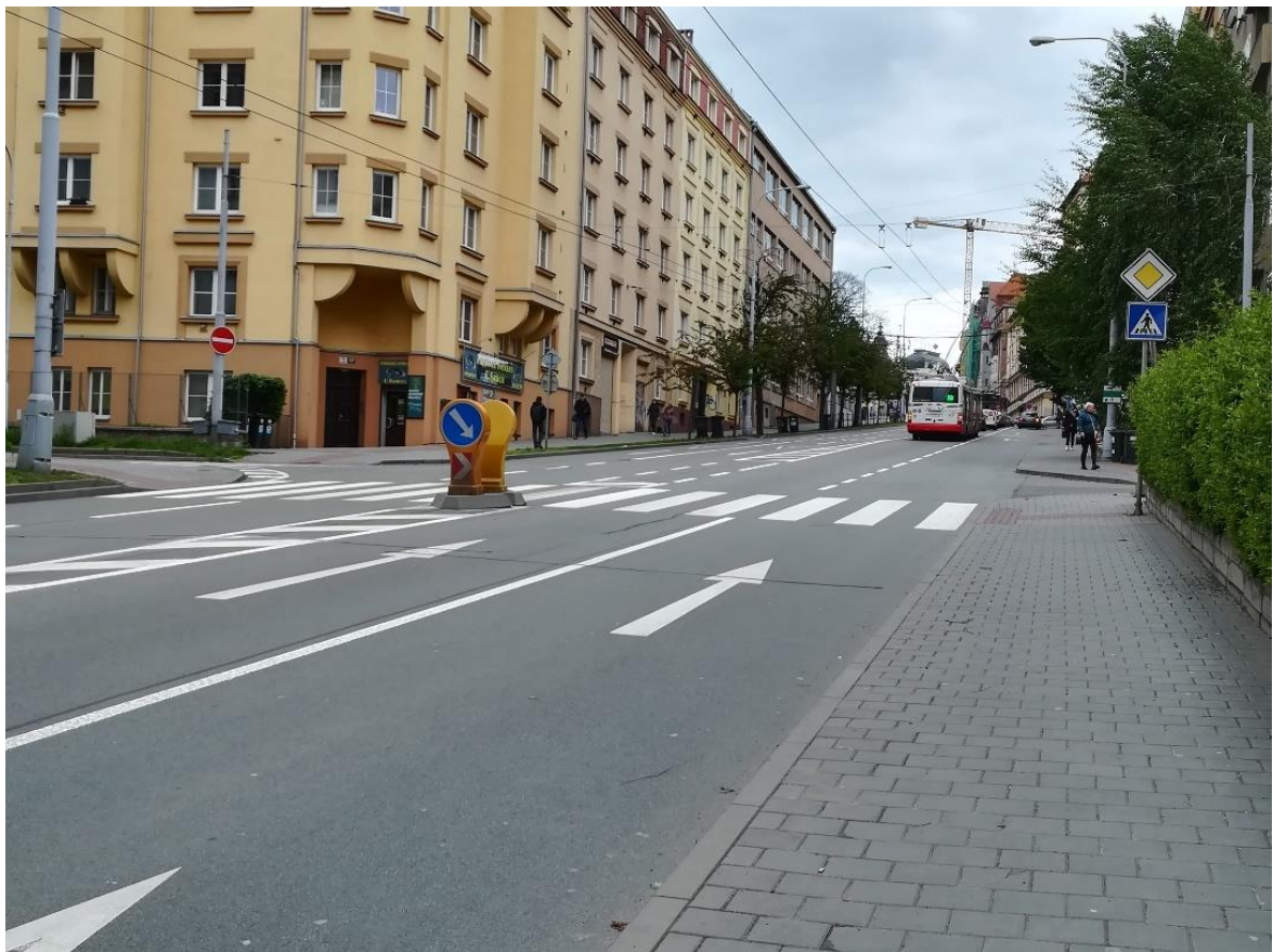
Obr. 14 - Přechod pro chodce na ulici Kotlářská
