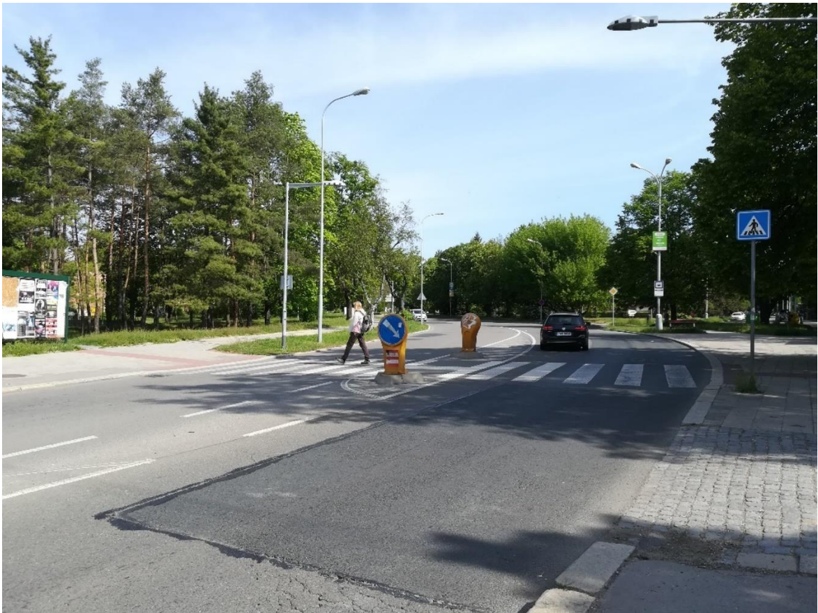
Obr. 34 – Přechod pro chodce na ulici Merhautova
