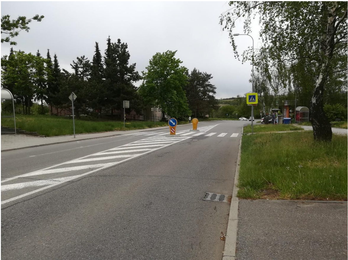
Obr. 46 – Přechod pro chodce na ulici Ukrajinská
