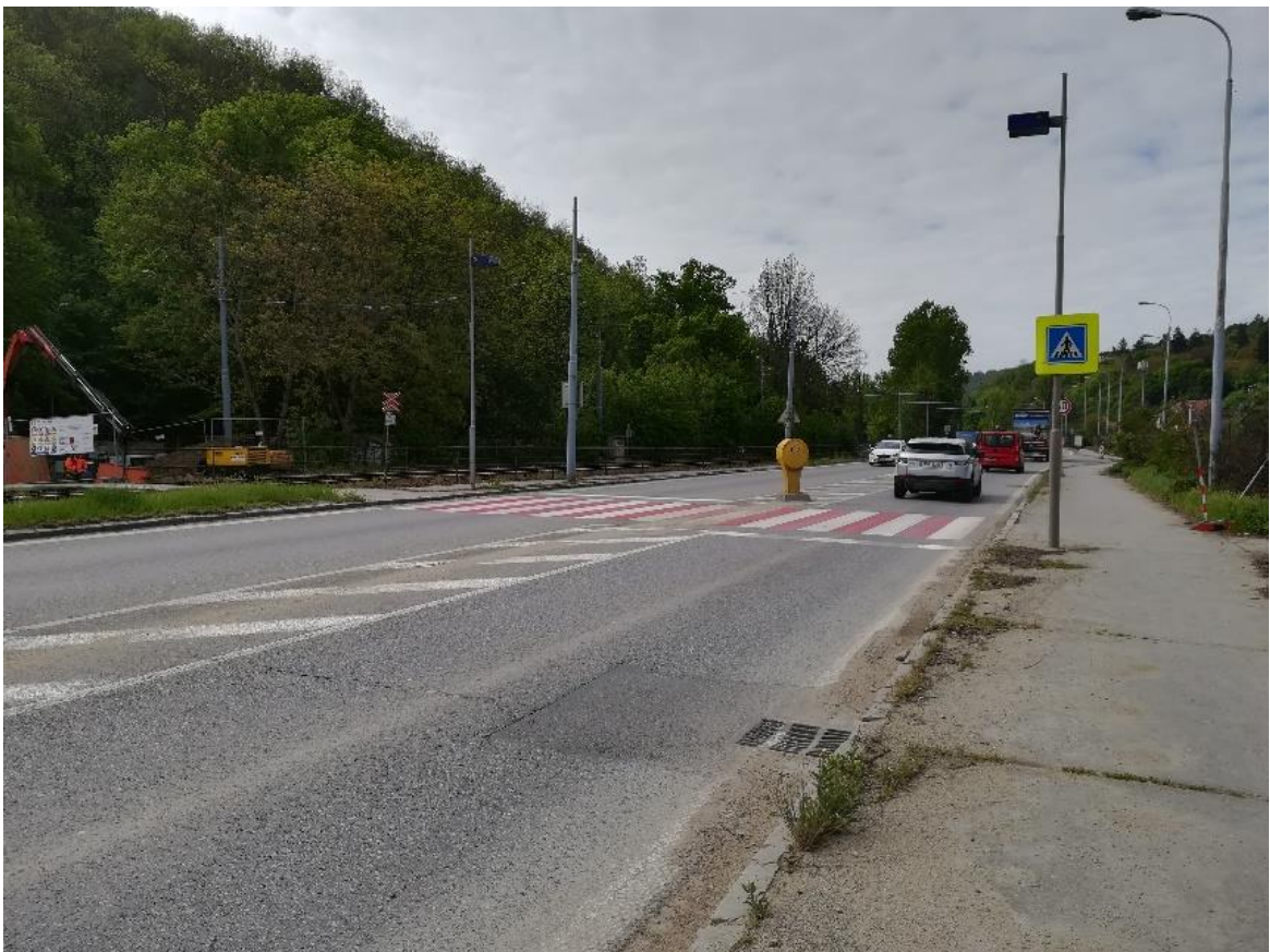
Obr. 56 – Přechod pro chodce na ulici Žabovřeská
