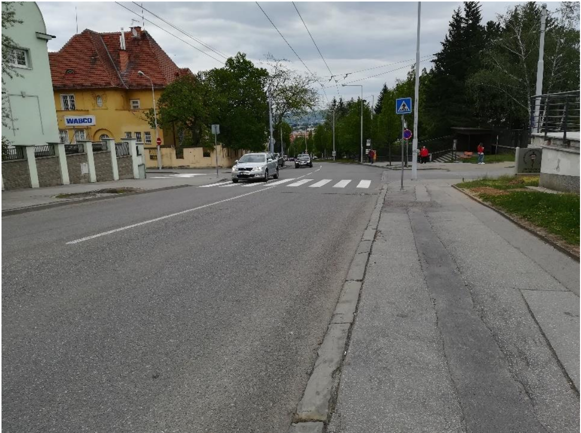
Obr. 35 – Přechod pro chodce na ulici Tvrdého
