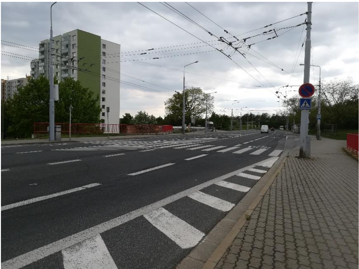
Obr. 68 – Přechod pro chodce na ulici Petra Křivky
