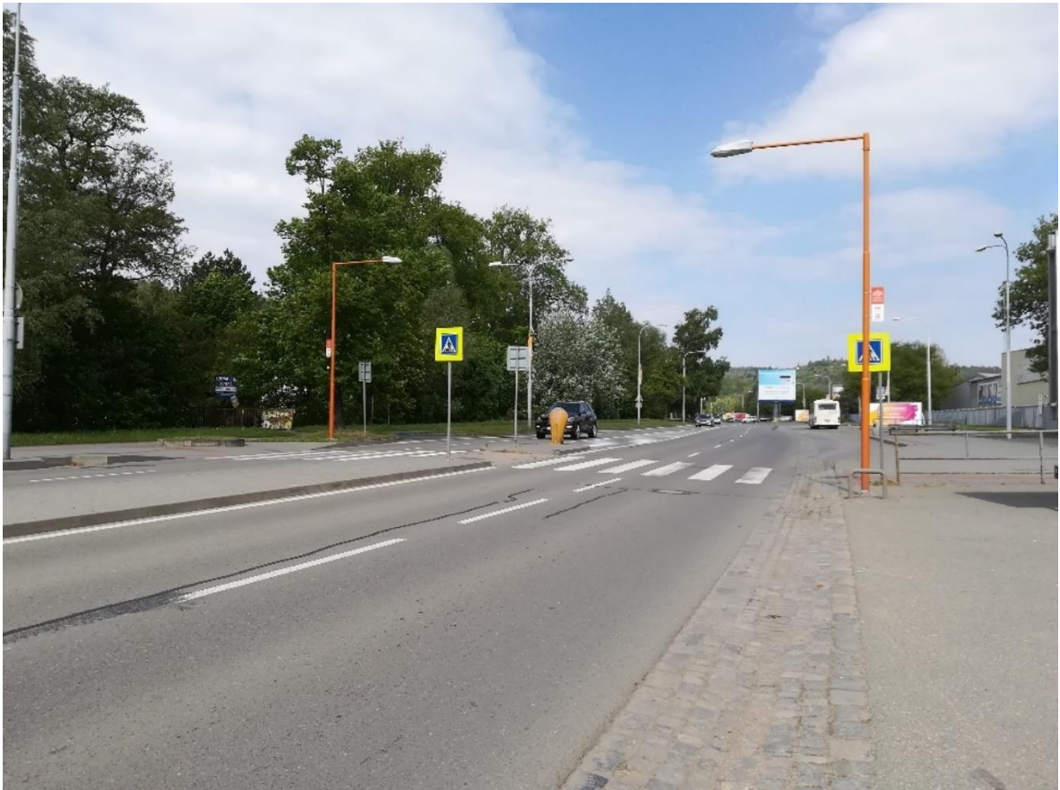
Obr. 28 – Přechod pro chodce na ulici Bauerova
