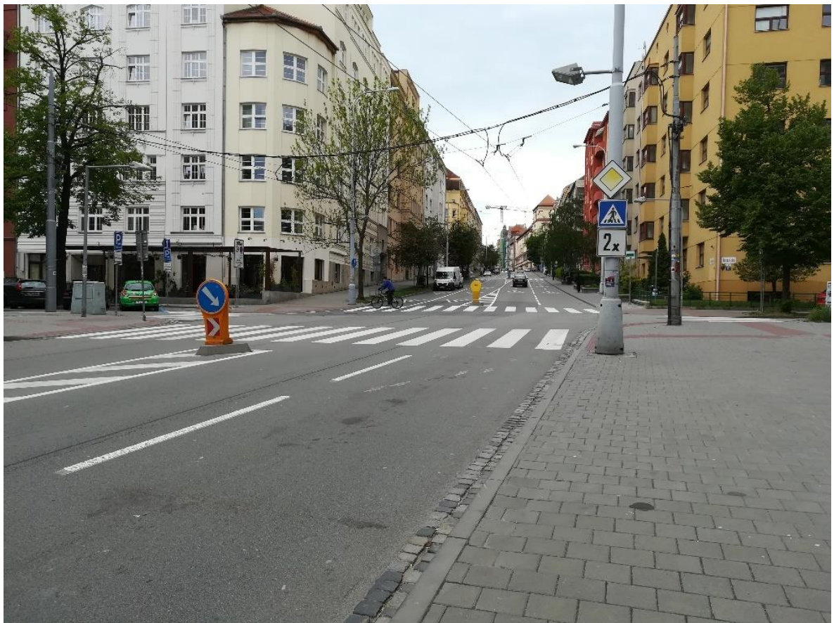
Obr. 13 – Přechod pro chodce na ulici Kotlářská
