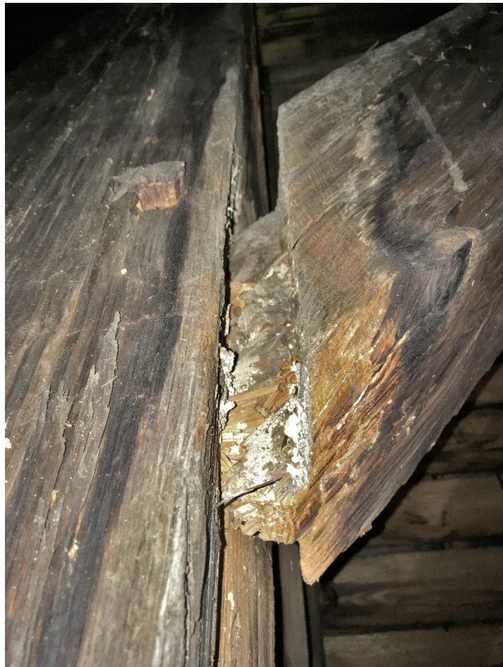
Obr. IV: Hniloba na sloupku a pásku
