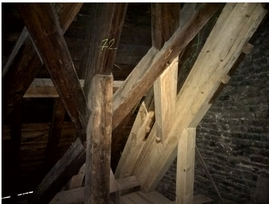
Obr. I: Nově nahrazené prvky sloupku LS, krokve, patního sloupku a ondřejského kříže v plné vazbě
