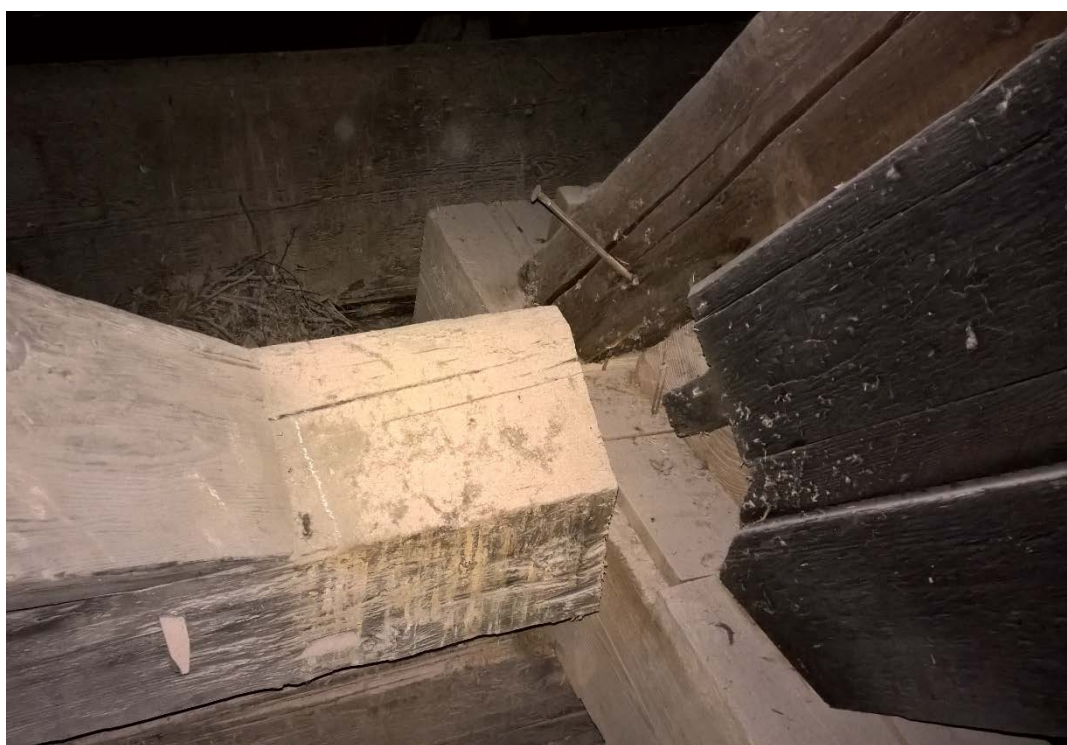
Obr. VI: Chybějící část pětibokého prahu v úrovni sloupku ležaté stolice
