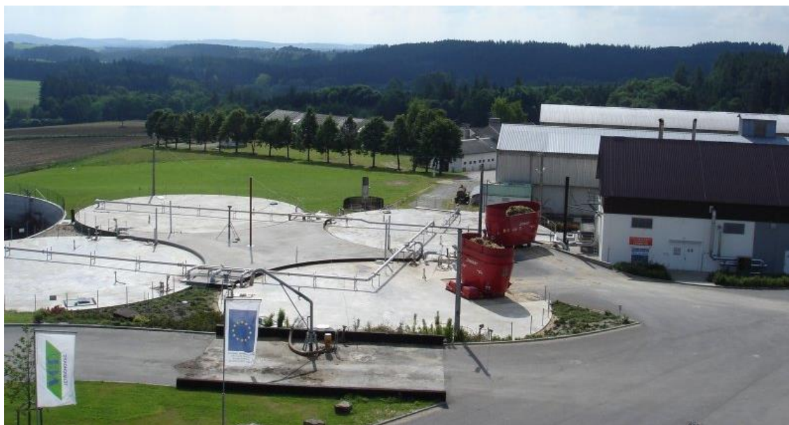
Obr. 13 Fermentační jímky a budova kogenerace BPS ve VOD Jetřichovec.
