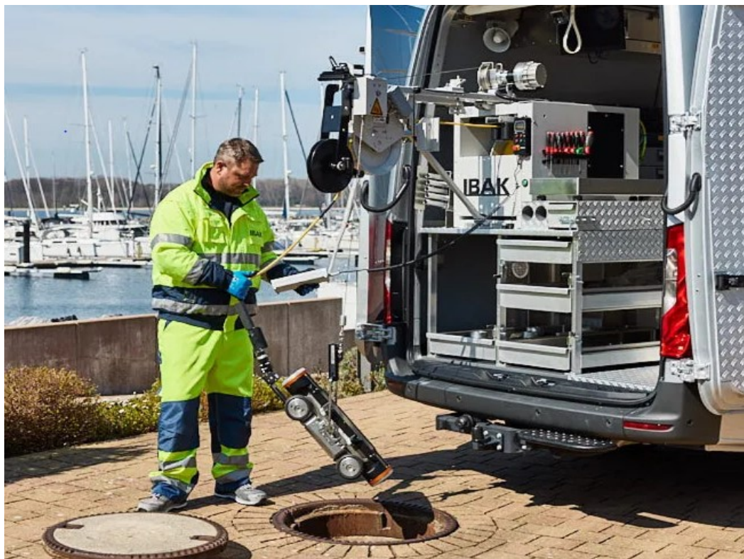
Obr. 4.2.2.1 Spouštění kamery PANORAMO 4K [9]
