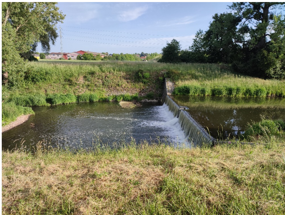
Obr. 6.2.3 8 Pohled na jez u OK95 [V. Bajza]
