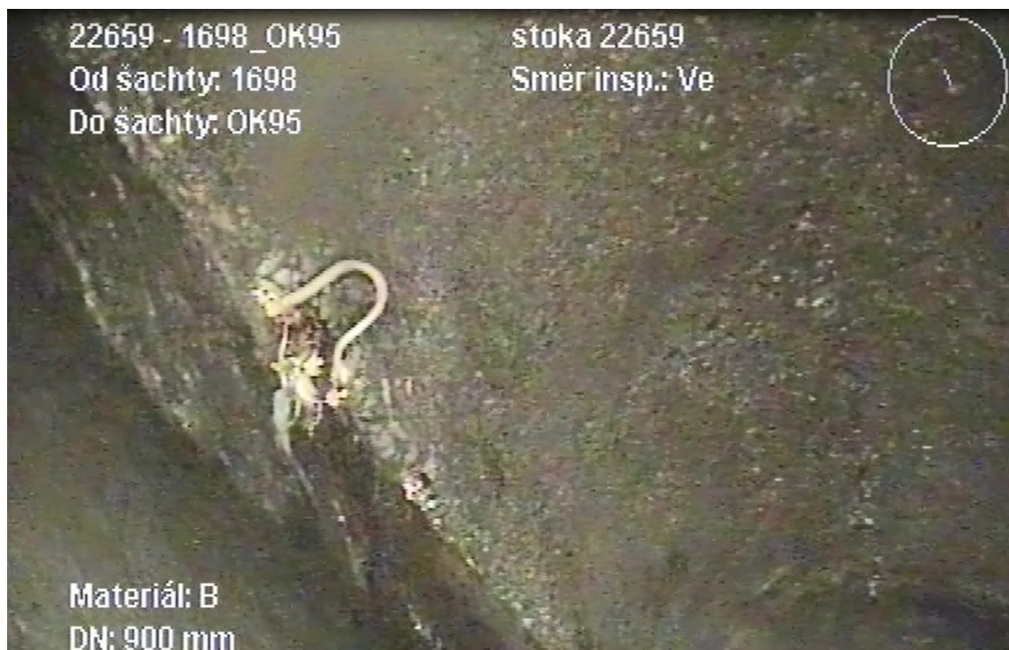
Obr. 6.2.1 10 Navrtaný otvor s drátem [V. Bajza]
