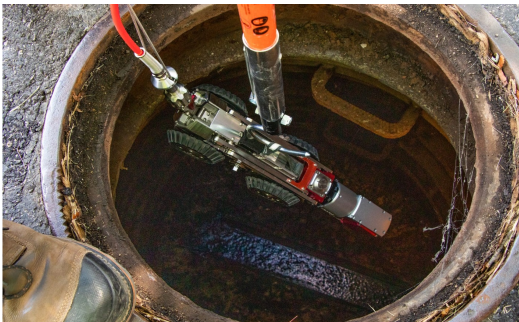
Obr. 4.2.2 3 Spouštění kamerového robota Voyager HD [10]
