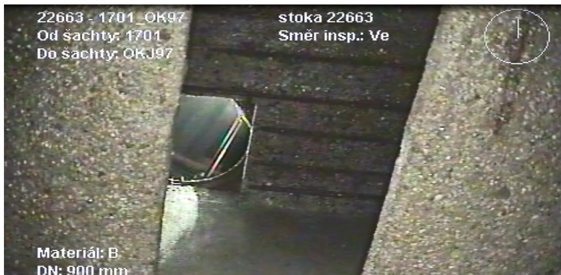
Obr. 6.2.2 1 Stav odlehčovací komory OK97 [V. Bajza]
