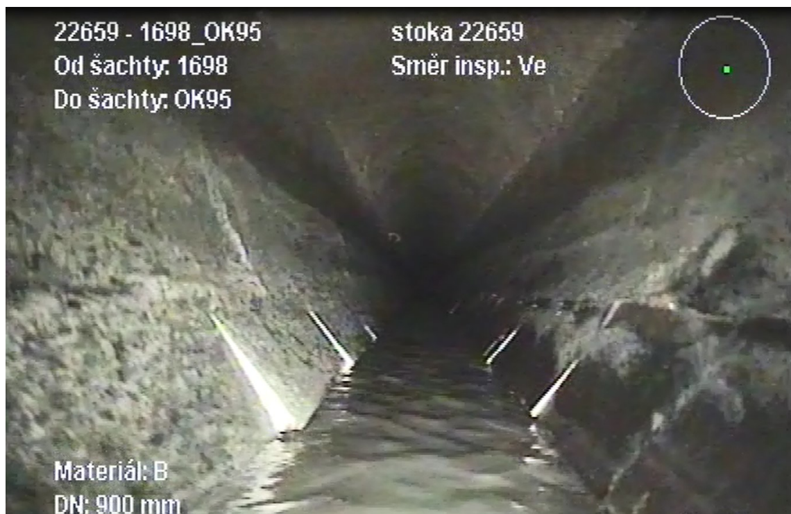
Obr. 6.2.1 12 Úsek s odstávajícími vložkami [V. Bajza]
