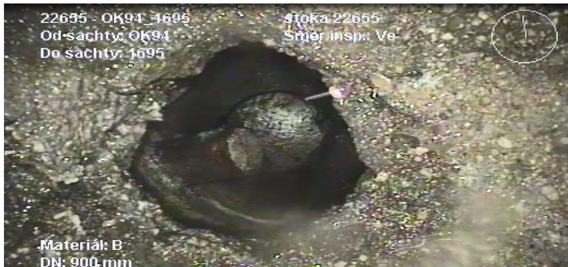
Obr. 6.2.11 Ilegální přípojka [V. Bajza]
