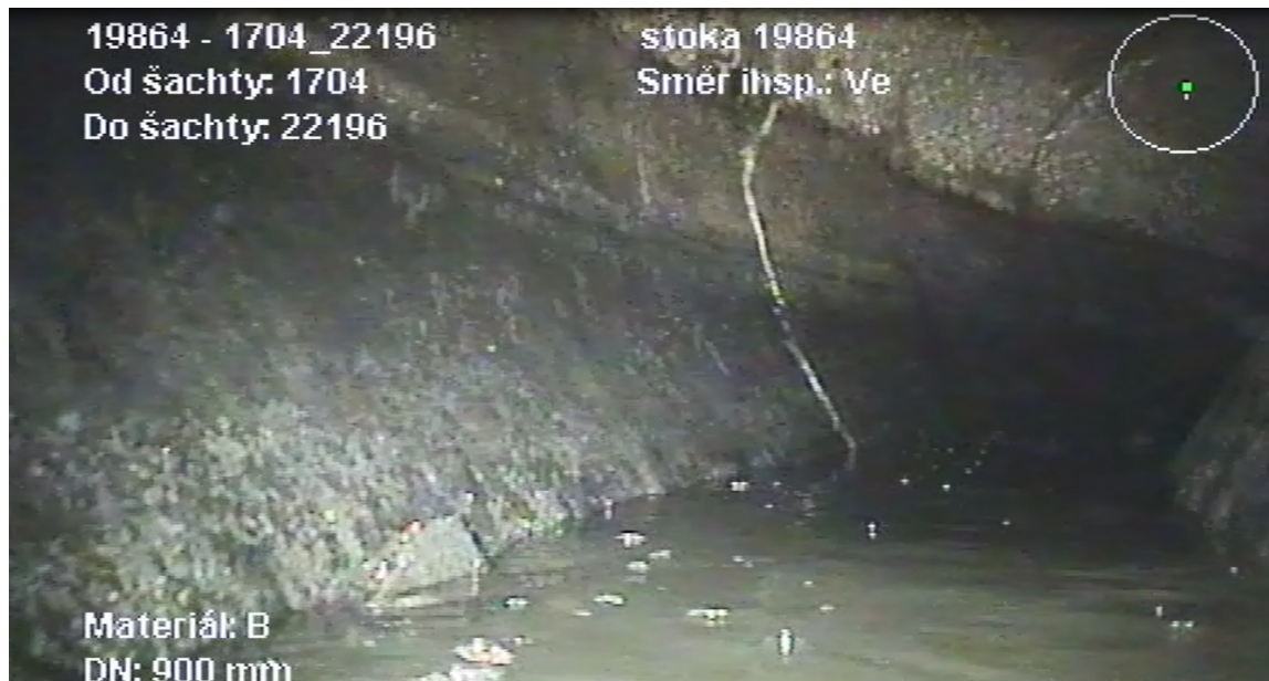
Obr. 6.2.1 21 Uvolněná vložka [V. Bajza]
