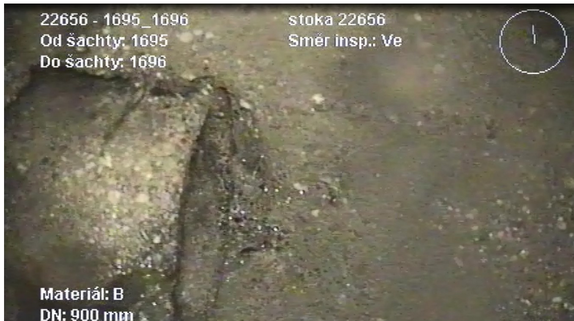
Obr. 6.2.1 3 Tesaná přípojka, netěsná [V. Bajza]
