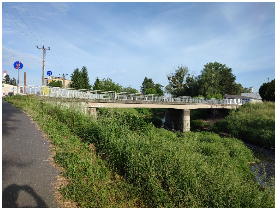
Obr. 6.2.3 13 Pohled na most vedoucí na ČOV Malenovice [V. Bajza]
