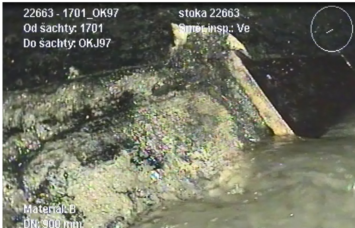
Obr. 6.2.1 18 Chybějící vložky [V. Bajza]
