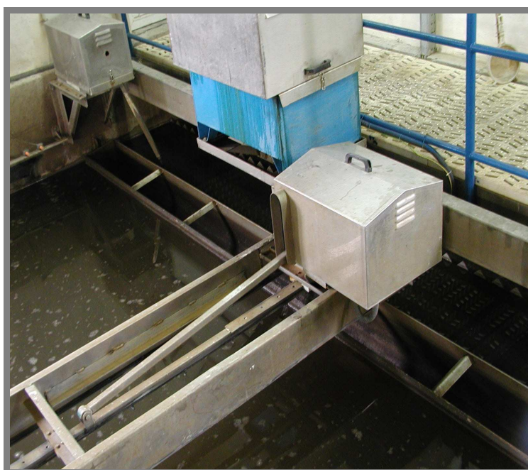
Obr.11 Detail pohonné jednotky zařízení Zickert
