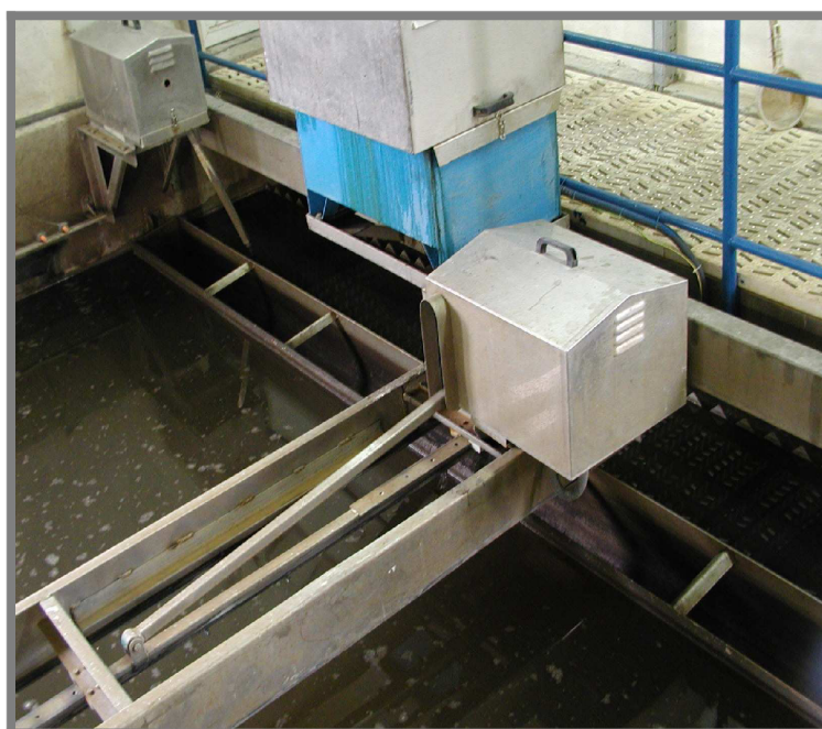
Obr.11 Detail pohonné jednotky zařízení Zickert
