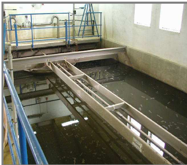
Obr.10 Systém na stírání hladiny Zickert
