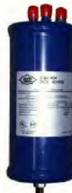
Obrázek 63 – Odlučovač oleje OSH [20]
