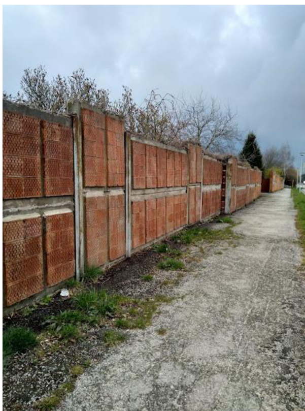
Obrázek č. 8: Protihluková stěna u stanoviště č.1
