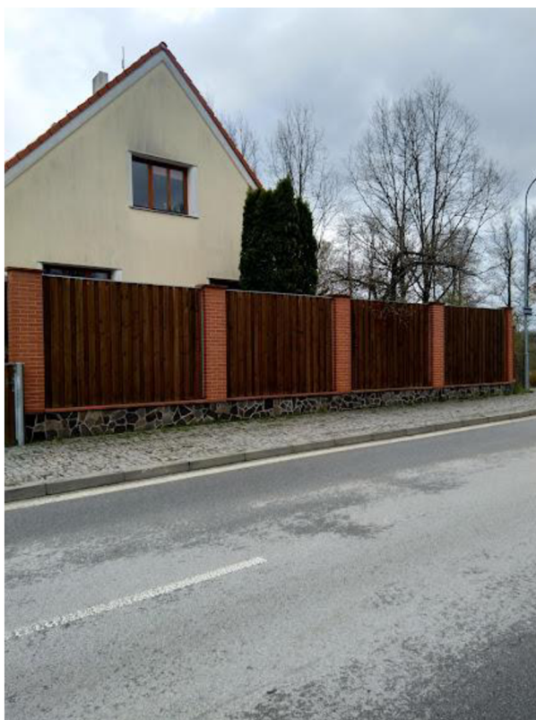
Obrázek č. 9: Protihluková stěna u komunikace II/154(Stanoviště č.2)
