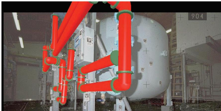
*Abbildung 18: Rohrleitungen Design in AR [39]*
