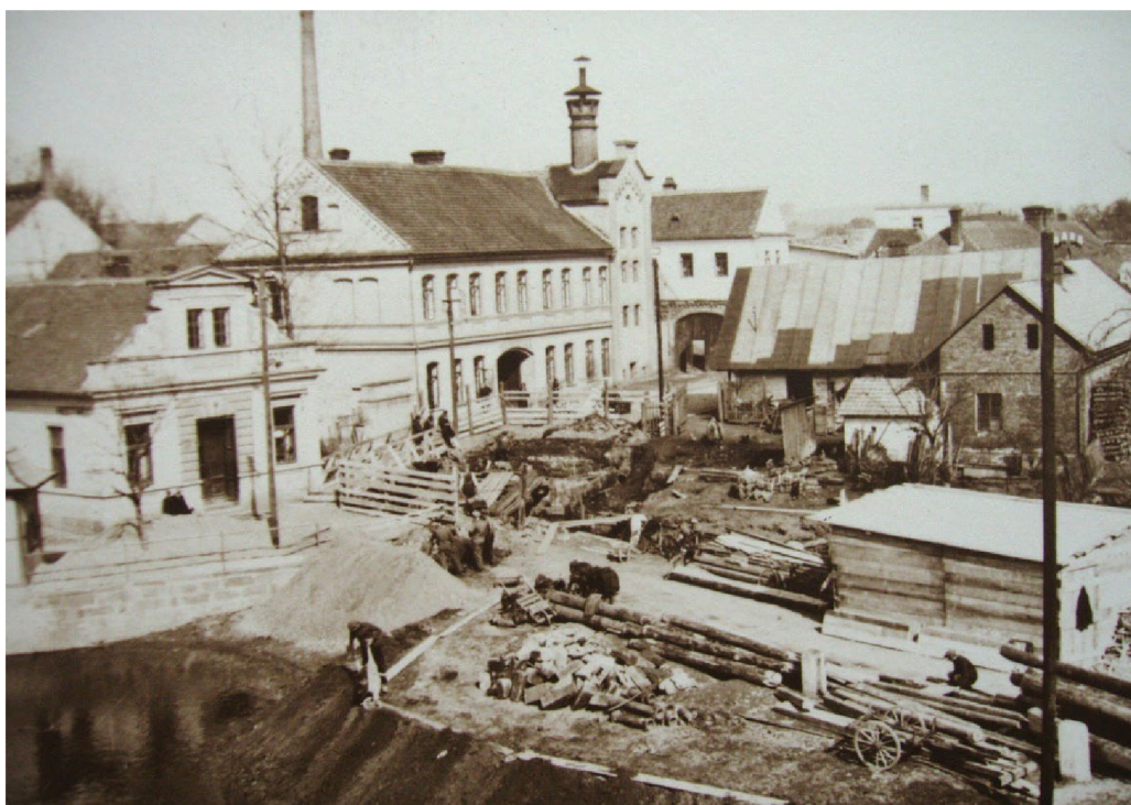
25. Regulace řeky Dědiny, výstavba vodovodu a kanalizace, 1930. Fotoarchiv TMB.
