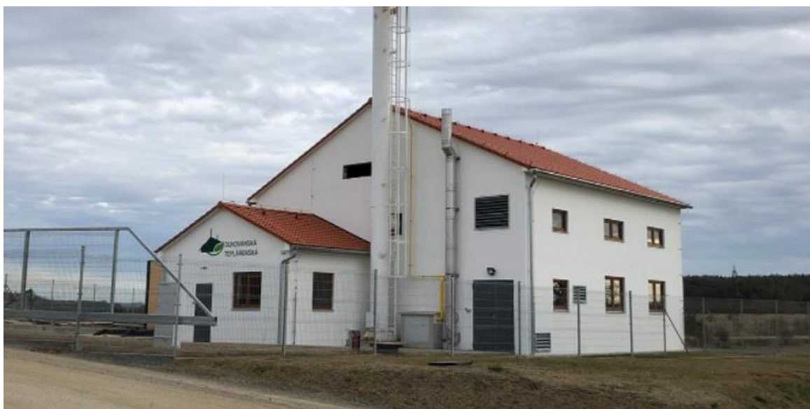
Obrázek 15: Objekt teplárny v obci Dukovany
