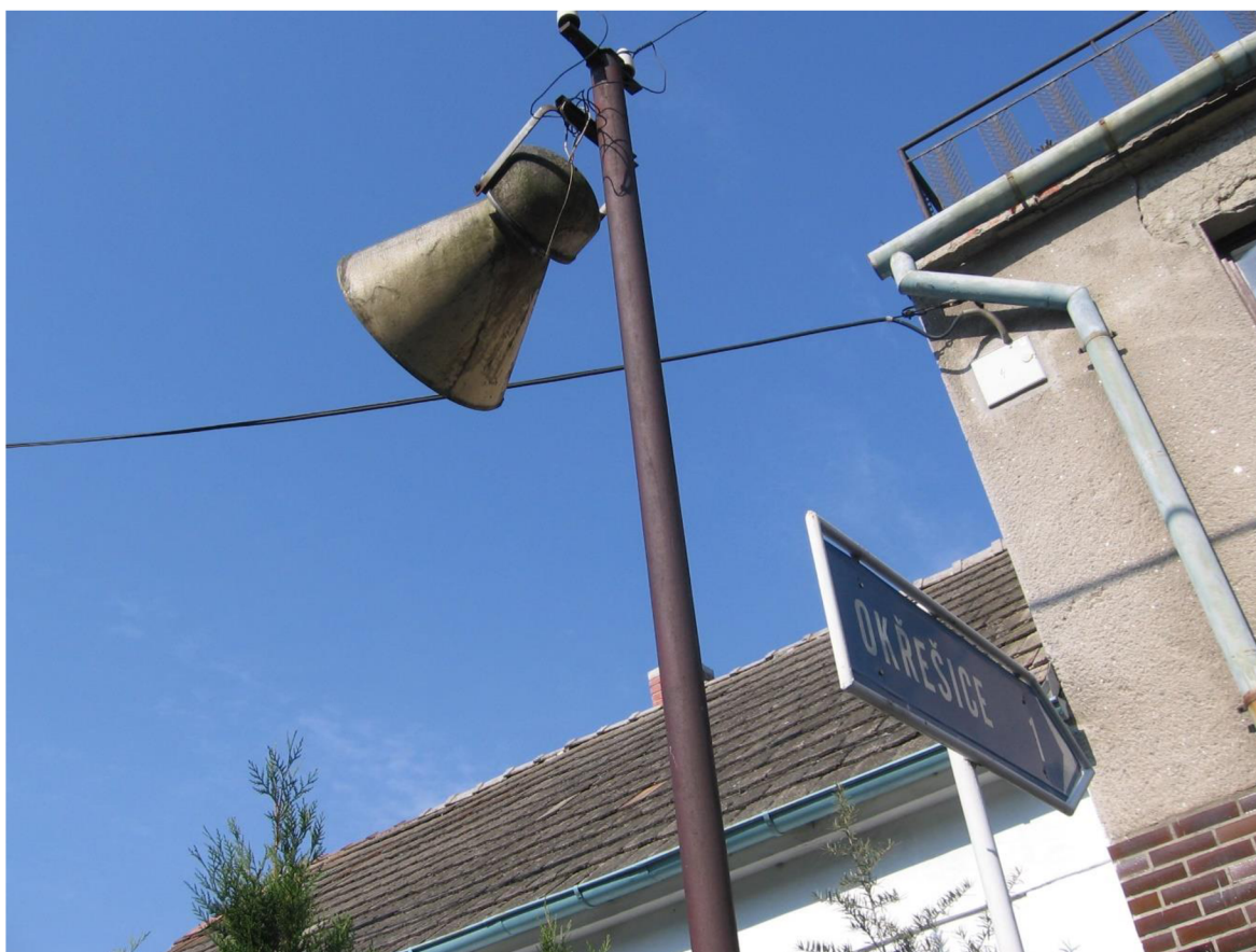
Obrázek 1: Venkovní reproduktor místního rozhlasu s drátovým vedením v místní části Budíkovice (Třebíč)
