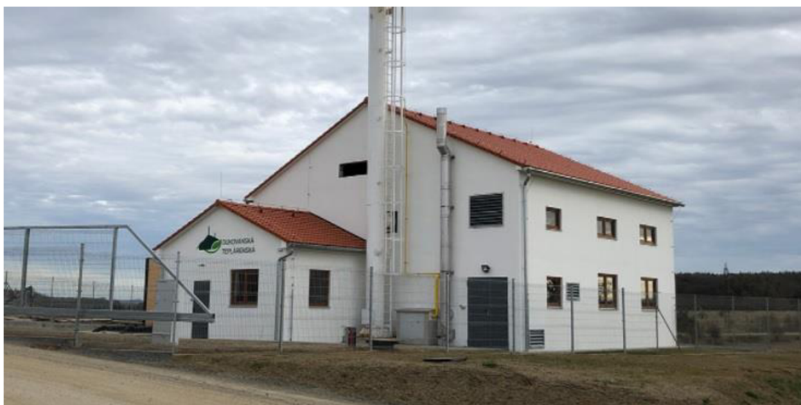
Obrázek 15: Objekt teplárny v obci Dukovany
