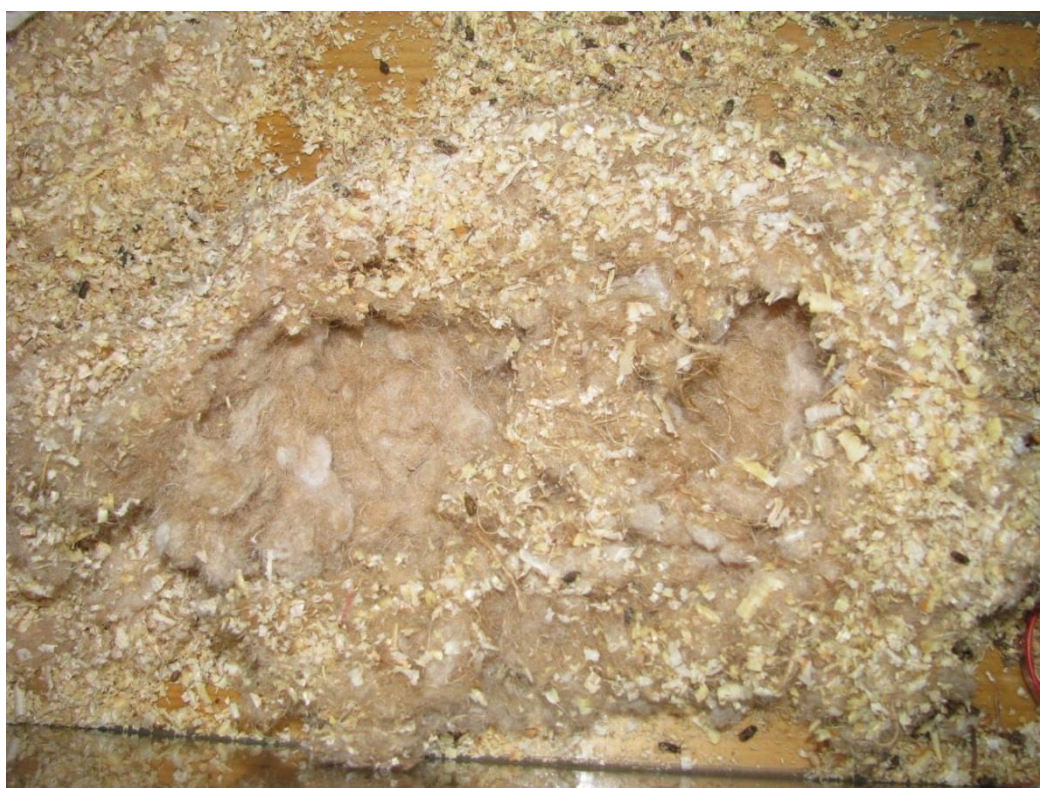
Obr 9. Naturizol po působení hlodavce. Zřetelné nory v izolantu. (Zdroj: vlastní foto)
