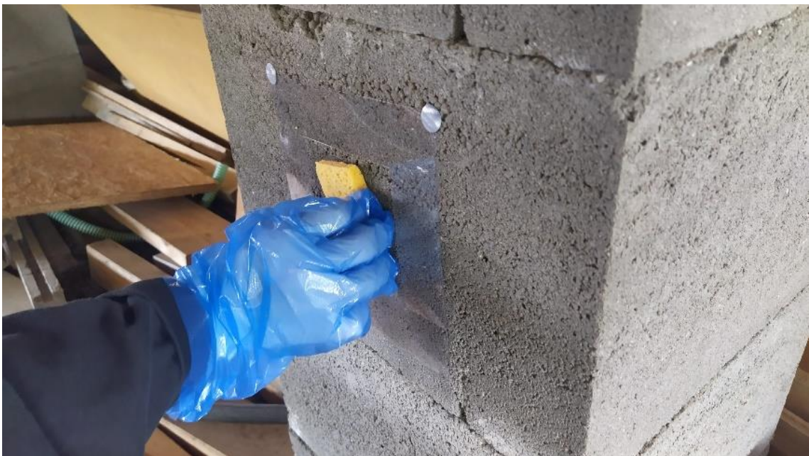
Obr. 4.9 – Stěr vzorků ze základové patky
