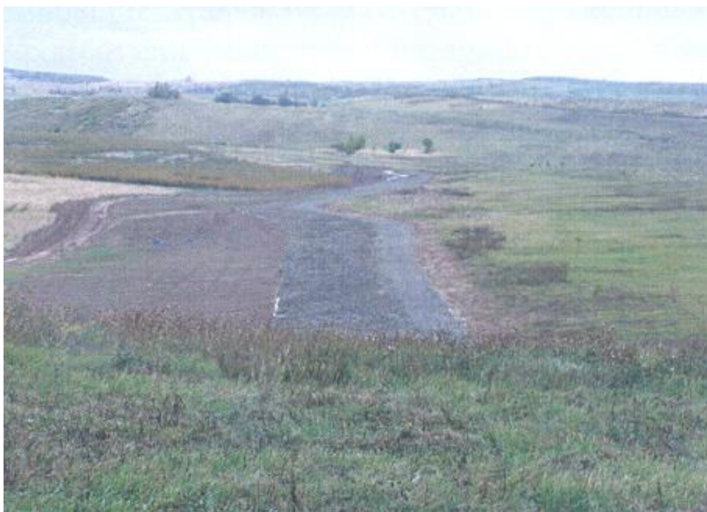
Foto č. 6: Opevnění a obvodová komunikace jezera Most. Na upravenou pláň byla položena geotextilie, na ni byl proveden pohoz z lomového kamene frakce 63 – 125 mm v mocnosti 300 mm a vše bylo ukončeno krytem z vibrovaného šterku v mocnosti 100 mm. Byla tak vybudována komunikace šíře 4 m v délce 9 815 m
