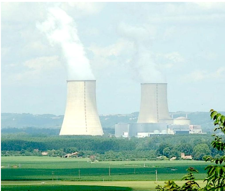
Jaderná elektrárna Golfech.
