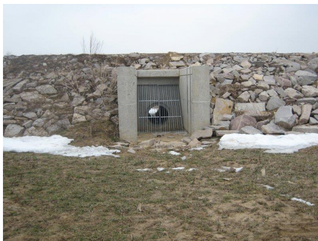
Obr. č. 11 - Odtokové zařízení suché nádrže (Katalog SZPÚ, 2010).
