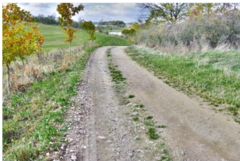
Obr. č. 29 - Stávající hlavní polní cesta SHPC 2, první část.
