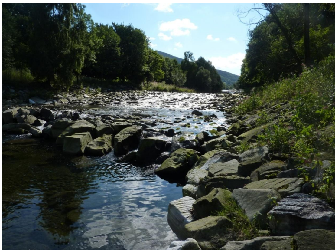
Obr. 4.4 Přírodní spádový stupeň na řece Morávce v srpnu 2011, kde došlo ke značným výmolům v místě rozšíření pod balvanitým skluzem (proti proudu) [14]
