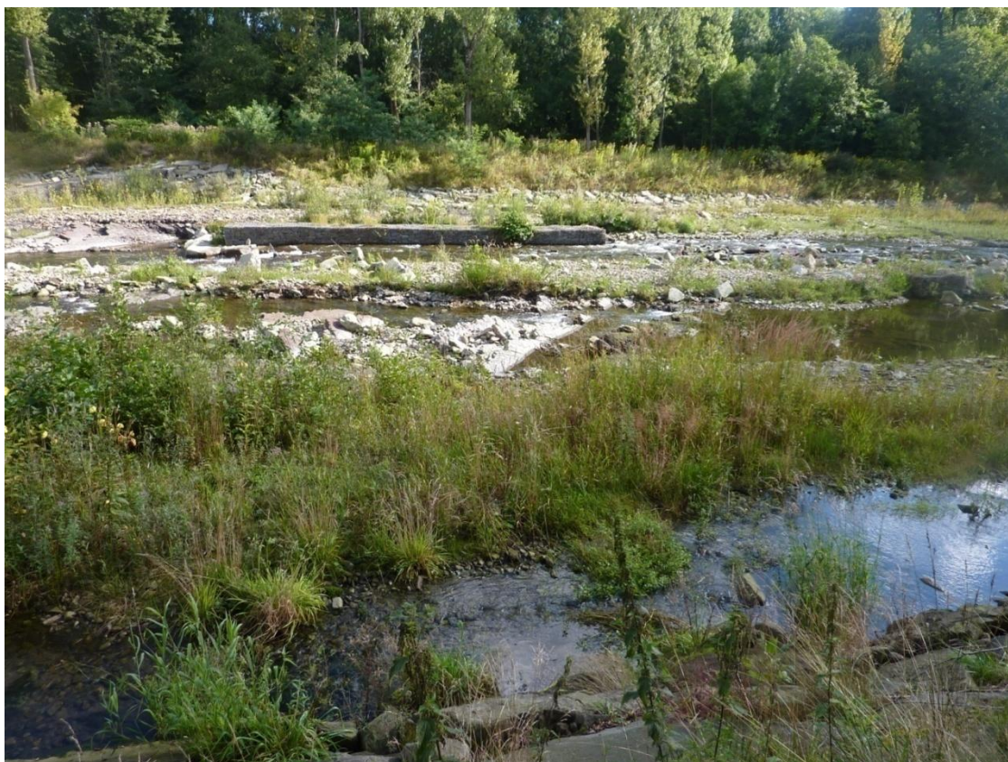
Obr. 2.3 Přírodní spádový stupeň na řece Morávce ve vegetačním období zarostlý travními porosty a dřevinami výrazně zvyšující celkovou drsnost koryta [14]
