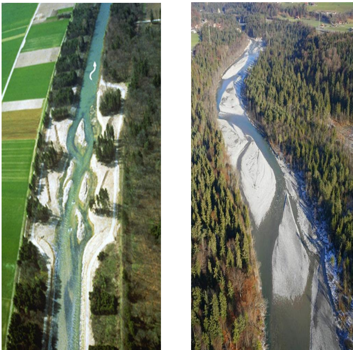
Obr. 2.13 Lokální rozšíření a zúžení koryta na řece Emmu (vlevo) a na řece Kander (vpravo) [15]
