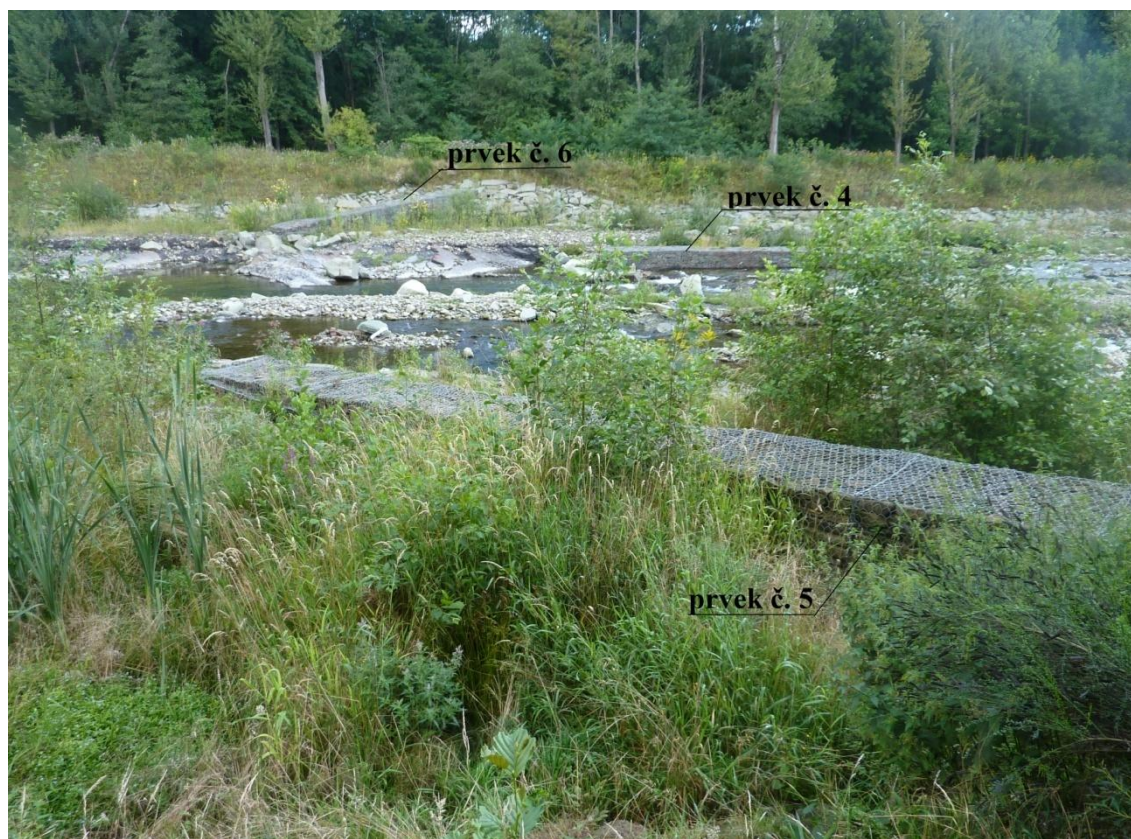
Obr. 4.8 Stav usměrňovacích prvků č. 4, č. 5 a č. 6 v srpnu 2011
