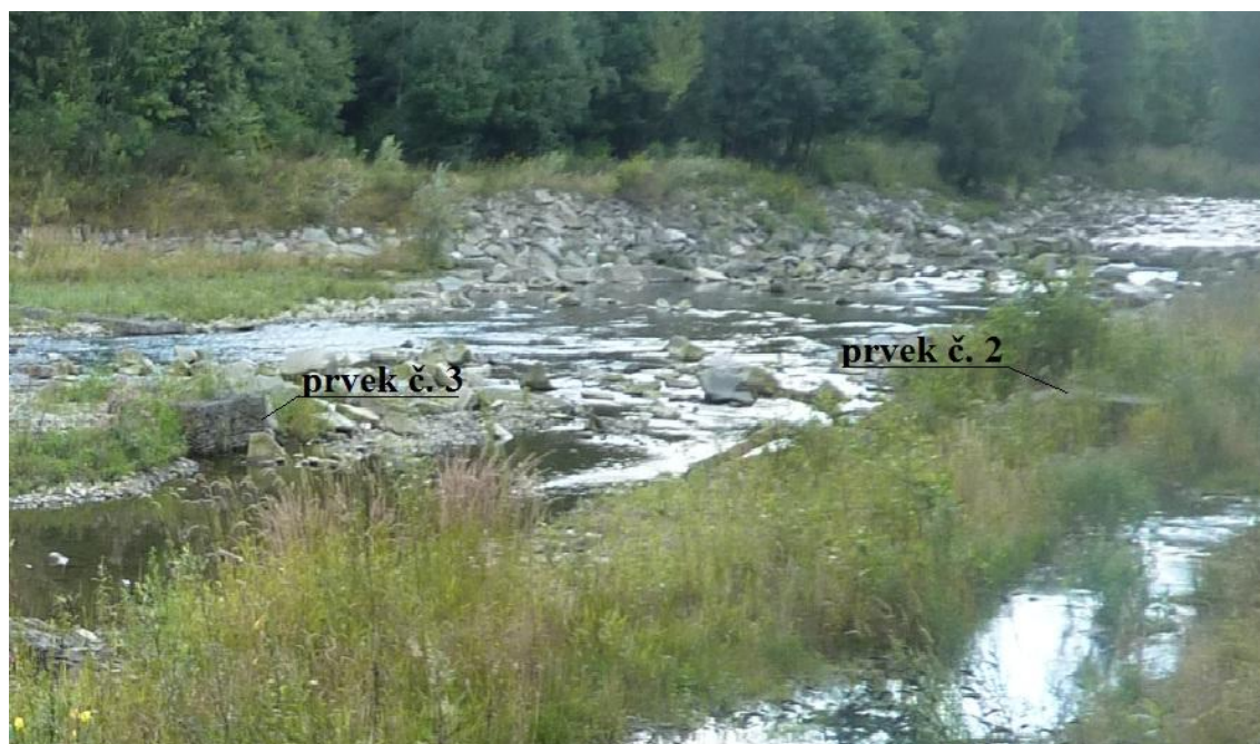
Obr. 4.6 Stav usměrňovacích prvků č. 2 a č. 3 v srpnu 2011 (proti proudu)
