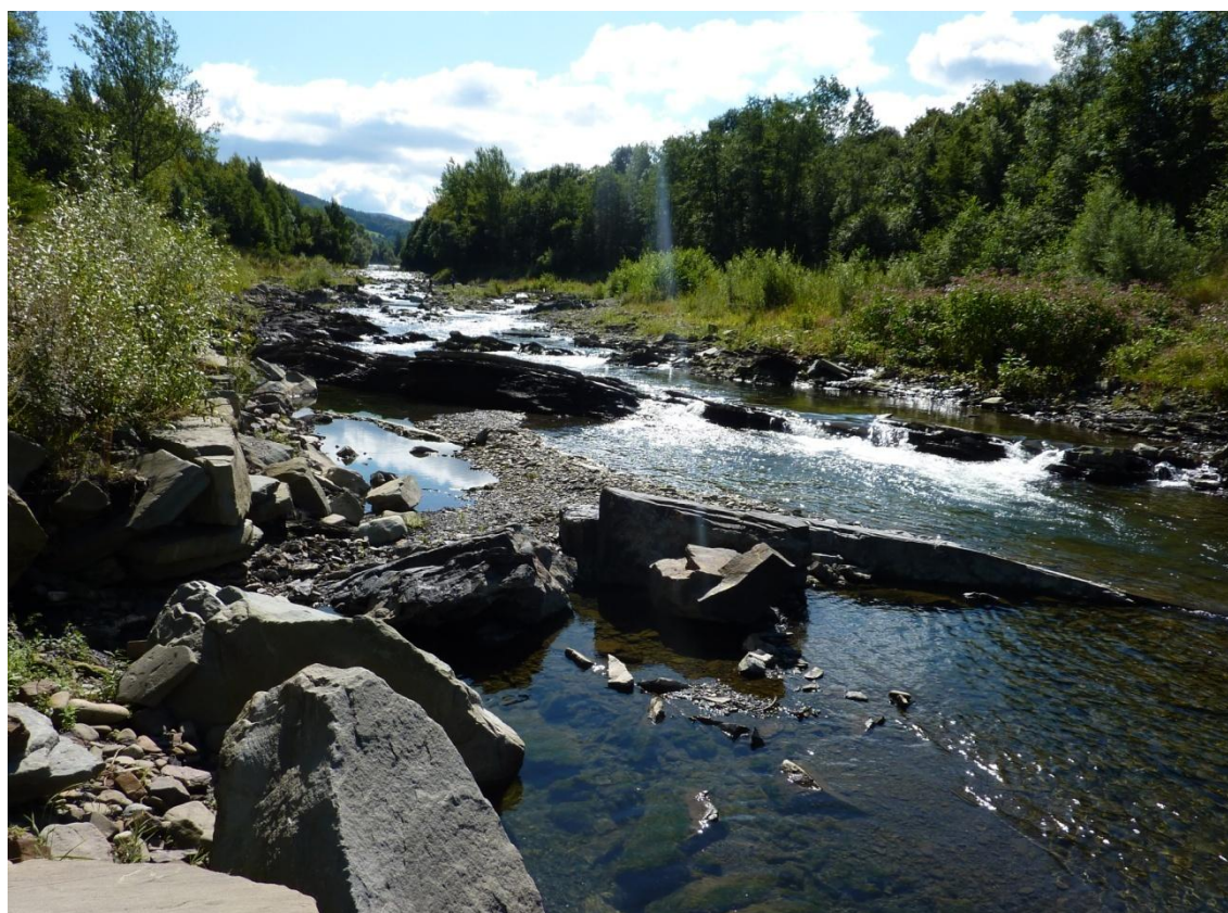
Obr. 4.9 Stav přírodního spádového stupně na řece Morávce v roce 2011, kde je patrný vznik skalních výchozů (proti proudu)
