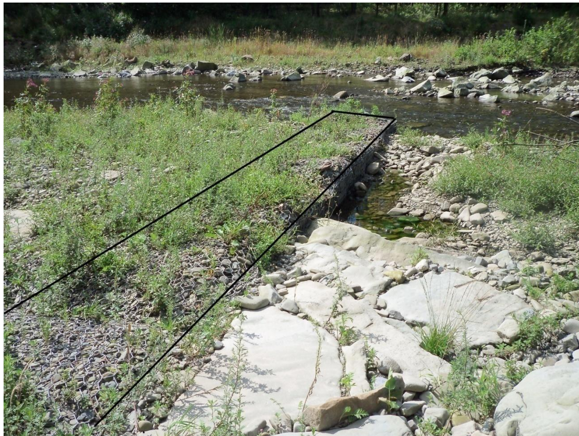
Obr. 4.5 Usměrnovací prvek č. 1 stav v srpnu 2011 (černý obrys naznačuje jeho původní stav).
