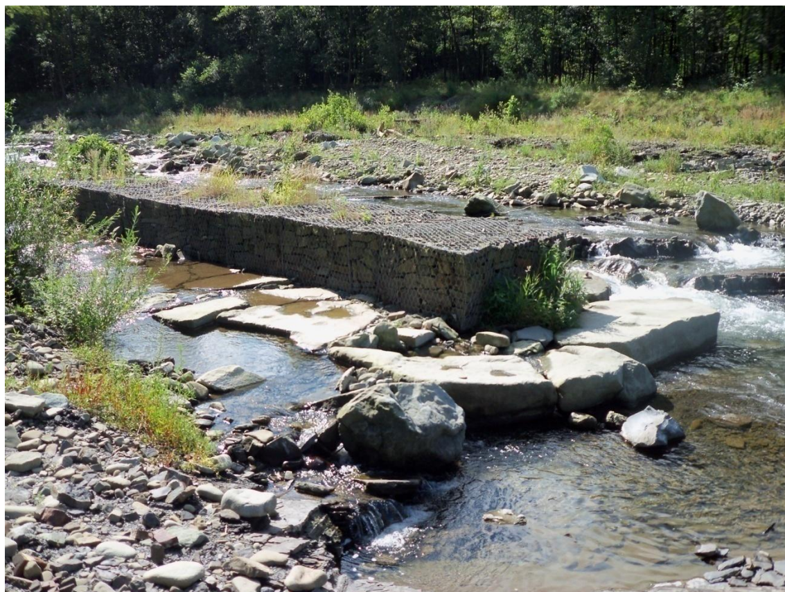
Obr. 4.7 Stav usměrňovacího prvku č. 4 v srpnu 2011 (proti proudu)
