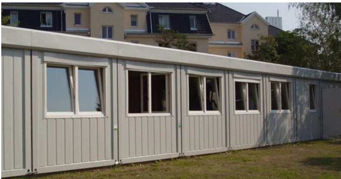
Příklad sestavy kontejnerů na staveništi
