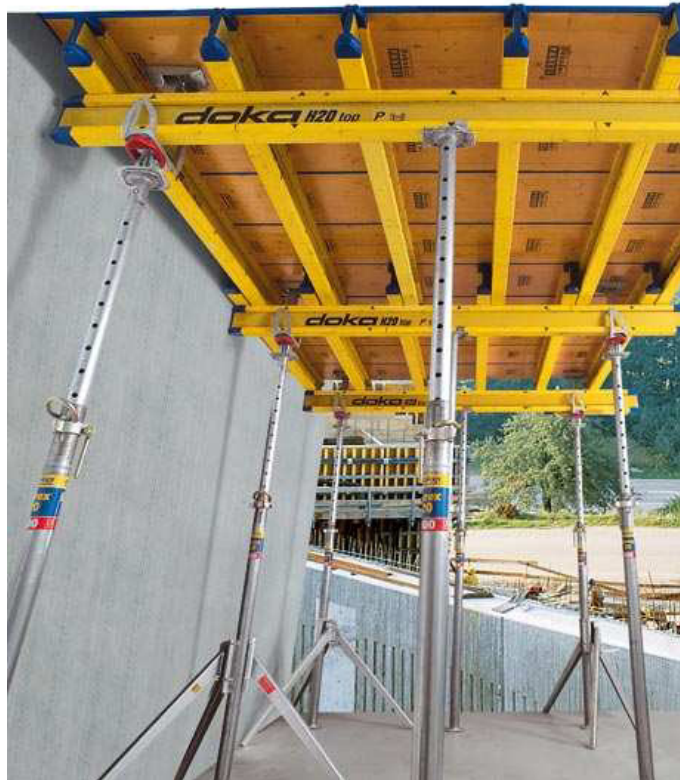
Obr. č. 3: Bednění vodorovných konstrukcí DOKA
