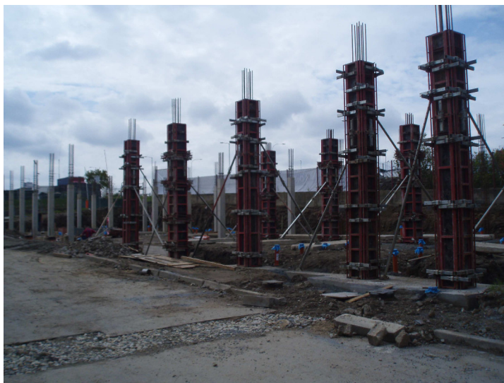
Obr. č. 2: Příklad bednění sloupu na reálné stavbě
