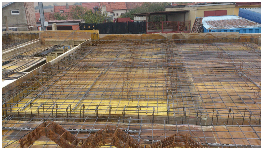
Obr. č. 5: Příklad uložení betonářské výztuže
