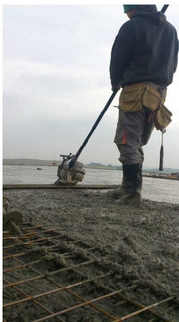
Obr. č. 8: Vodorovné urovnání betonu vibrační lištou
