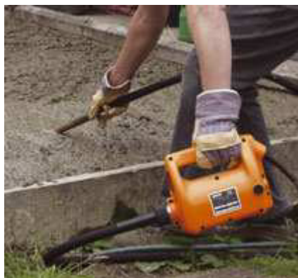
Obr. č. 7: Hutnění ponorným vibrátorem
