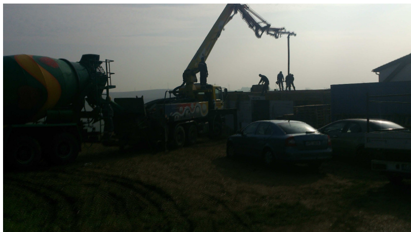
Obr. č. 6: Čerpání betonové směsi
