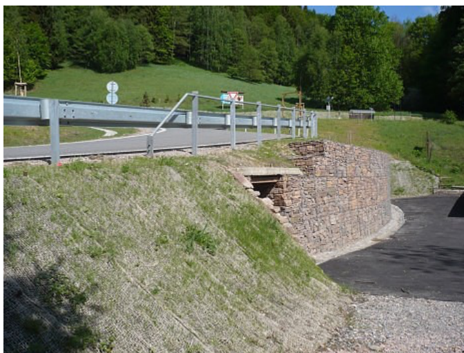
Obrázek 12 - Instalovaná jutová geotextilie (Geomat, 2023)
