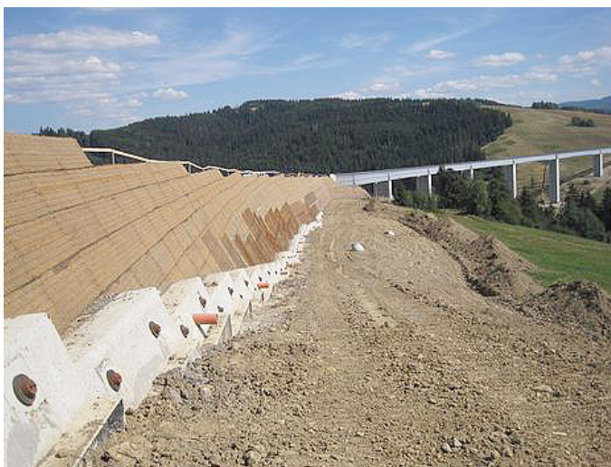
Obrázek 4 - Sanace vyztužené zeminy (Geomat, 2023)
