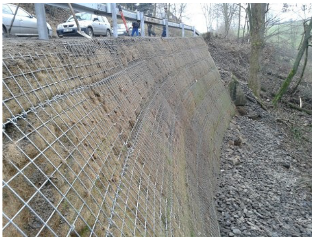
Obrázek 3 - Sanace sesuvu svahu v Jablonci nad Nisou (Geomat, 2023)
