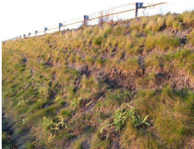
Obrázek 10 - Špatně zvolený protierozní prvek (Podnikelský, Grepl, 2022)
