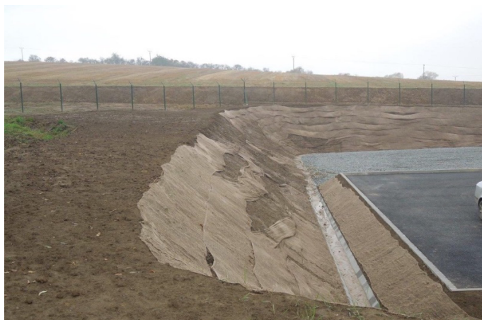
Obrázek 7 - Špatně položená jutová geotextilie (Zýka, 2022)
