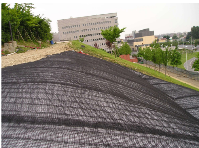
Obrázek 14 - Instalovaná geozohož 20 cm pod povrch svahu (Podnikelský, Grepl, 2022)
