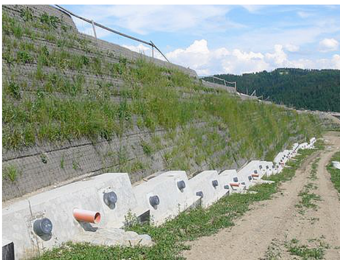
Obrázek 5 – Následné zazelenění povrchu geomříže (Geomat, 2023)
