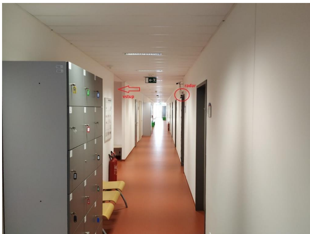
Obr. 6.2 Pohled na radar z levé části chodby
