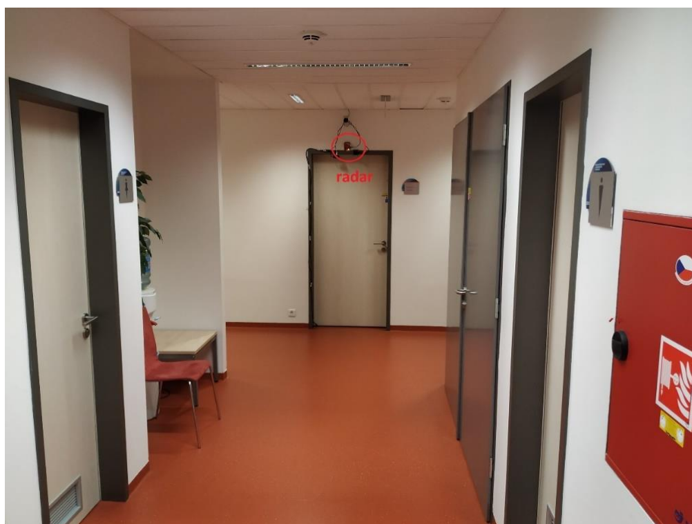
Obr. 6.3 Pohled na radar zepředu (od vstupu)
