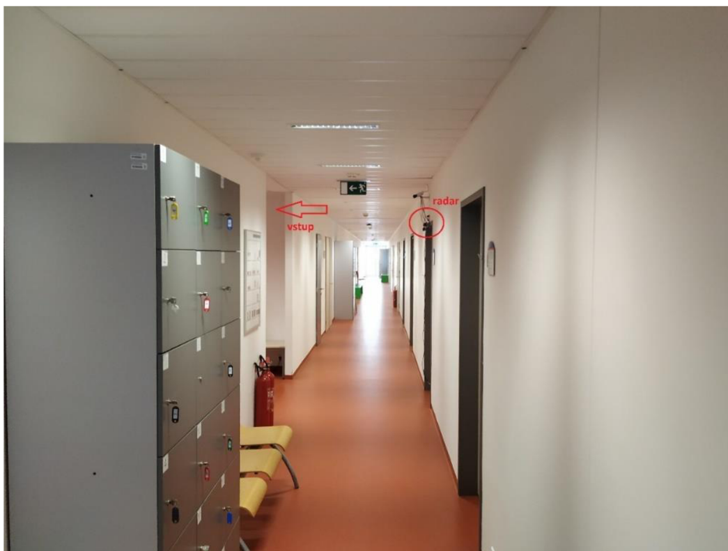
Obr. 6.2 Pohled na radar z levé části chodby
