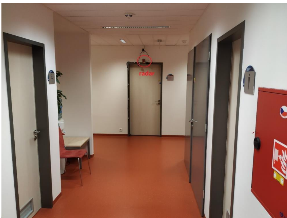
Obr. 6.3 Pohled na radar zepředu (od vstupu)
