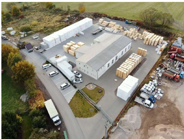
Obr. č. 2: Budova s komunikacemi a skladovacími prostory – foto: autor práce
