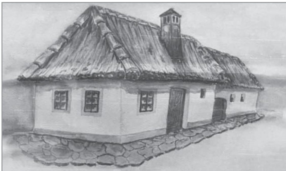
Obráz domku č. p. 48 z roku 1781. (BŘEČKA, Jan a Jiří MITÁČEK. Hluk: dějiny města . s. 246)
