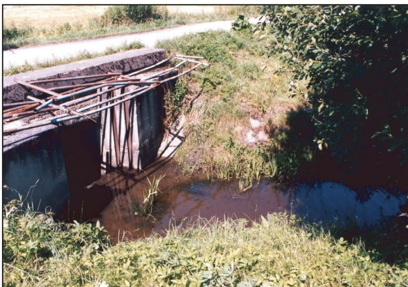
Lokalita D5: Dobečovský potok v Dobechově u mostu
