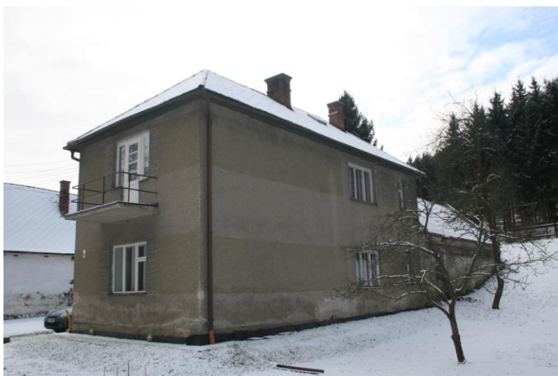
Obr.23 Reprezentativní objekt (severovýchodní pohled)
