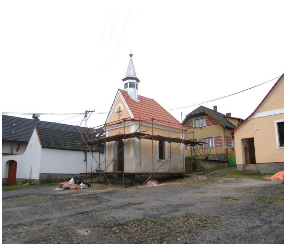
Obr. č. 84 kaple Doubravice Foto: autor
