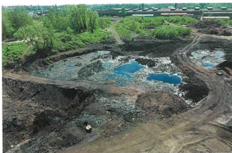
Halda POLDI – nahoře – zahájení likvidace dehtových jezírek, dole – současný stav sanačních prací – „promývání“ kontaminovaných vrstev pod bývalými jezírky
