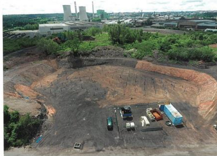
Halda POLDI – nahoře – zahájení likvidace dehtových jezírek, dole – současný stav sanačních prací – „promývání“ kontaminovaných vrstev pod bývalými jezírky
