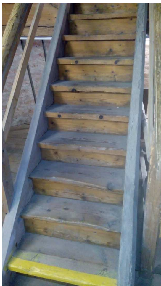
Obr. 9 Samonosné rovnoramenné schodiště věže, Tovačov.
