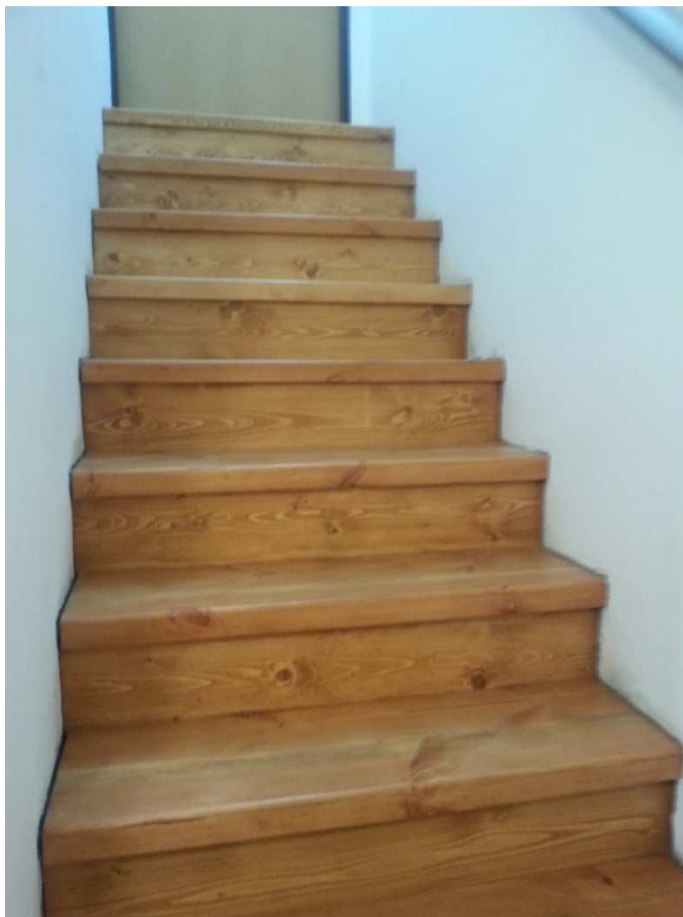
Obr. 4 Namontované schodiště v rodinném domě
