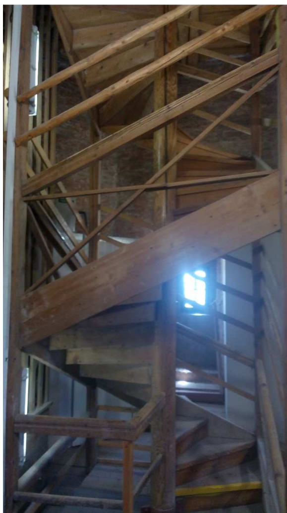
Obr. 8 Samonosné vřetenové schodiště věže, Tovačov.
