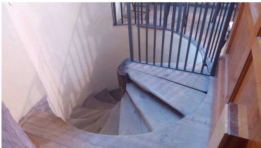
Obr. 10 Schodiště vřetenové (výstup na choru), kostel Konice
