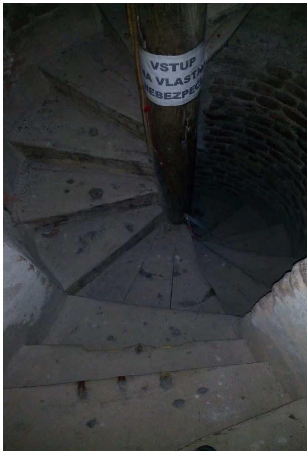
Obr. 11 Vřetenové schodiště věže na zvonici, kostel Konice
