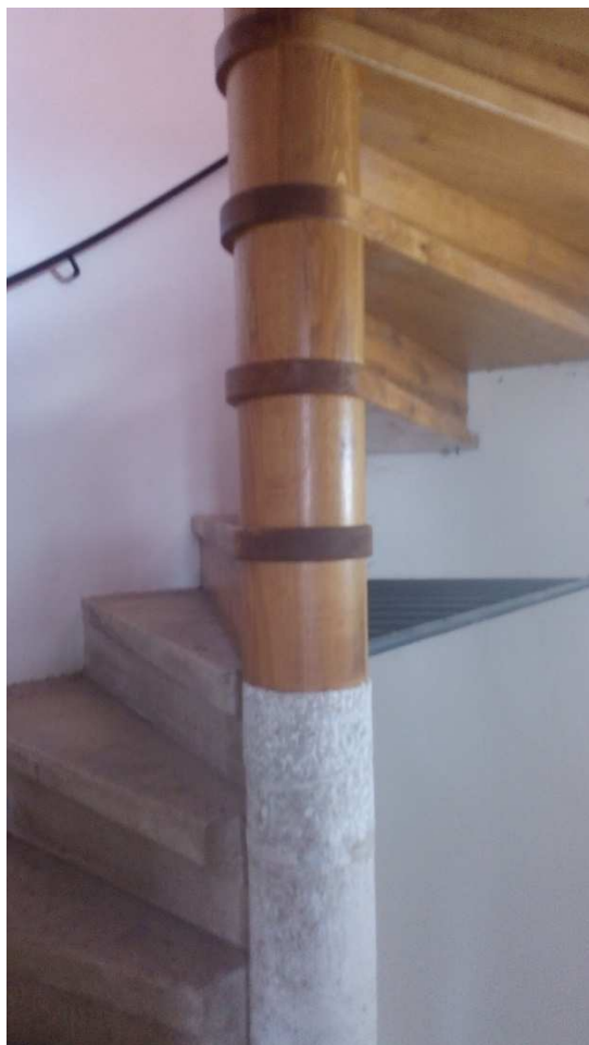
Obr. 7 Vřetenové schodiště věže, Tovačov.
