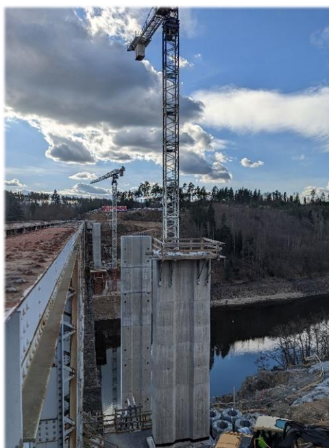
Obrázek 42: Nový železniční most ve výstavbě, dokončení 2024, archiv Petra Zadražila
