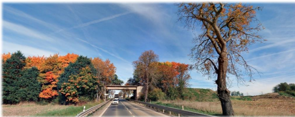
Obrázek 3: Železobetonový nadjezd přes silnici I/4 Praha - Písek, pohled směr Praha, vpravo je zřetelný výřez v bývalém tělese dráhy pro budoucí dálnici D4 (Mapy.cz, 2022)
