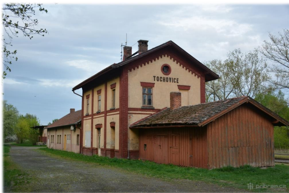
Obrázek 2: Tochovická nádražní budova z 19. století, v popředí dřevěná administrativní budova pro potřeby vlečky (Boháč, 2018)
