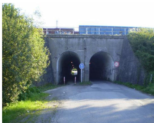
Obr. 5: Silniční dvojviadukt (foto: Szczygielová, E., 2010)
