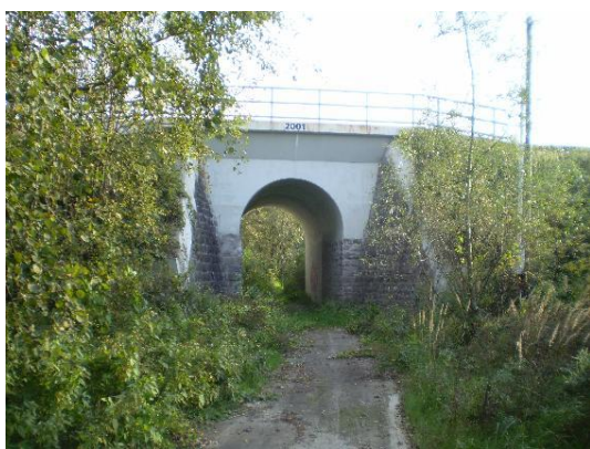
Obr. 4: Viadukt pro pěší (foto: Szczygielová, E., 2010)
