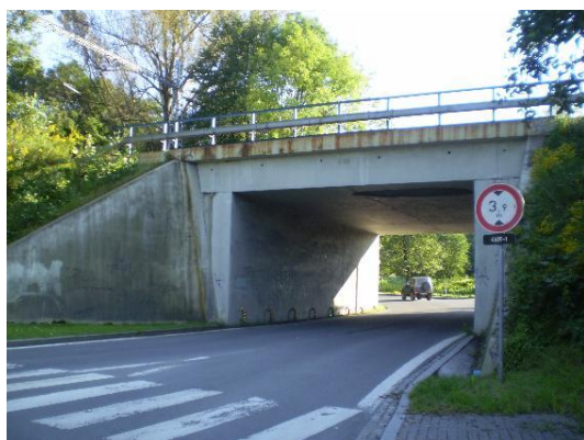
Obr. 6: Silniční podjezd (foto: Szczygielová, E., 2010)
