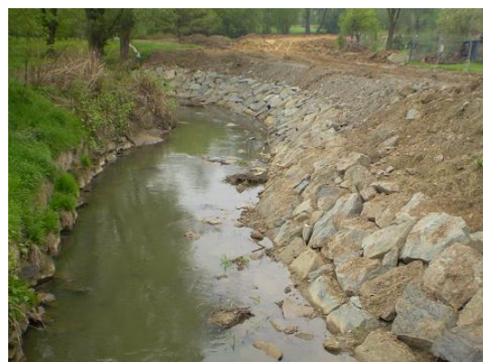
Obr. 26 : Průběh výstavby zemní hráze na 10,873 ř. km v dubnu 2011 (foto: Szczyielová, E., 2011)
