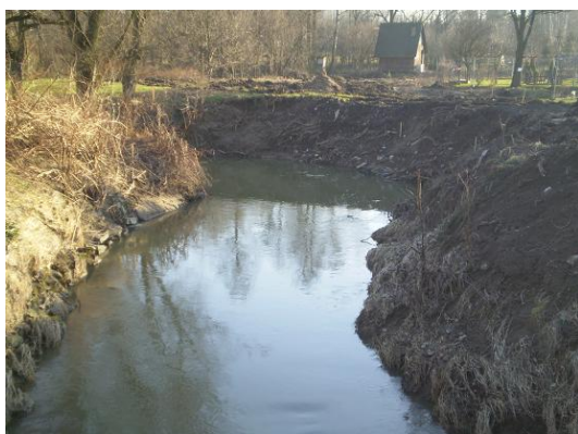
Obr. 25: Průběh výstavby zemní hráze na 10,873 ř. km v únoru 2011 (foto: Szczyielová, E., 2011)
