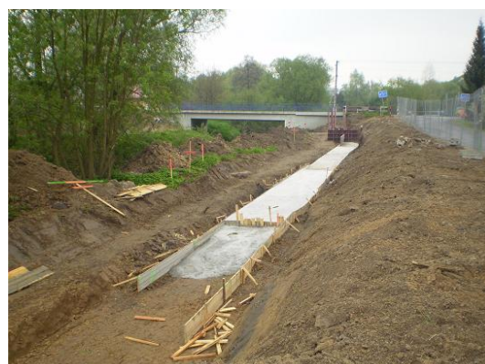
Obr. 28: Průběh výstavby betonové stěny na 9,938 ř. km v dubnu 2011 (foto: Szczyielová, E., 2011)
