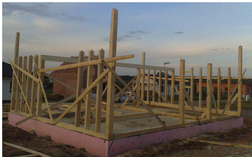
Obr. 7- Po ukotvení patních trámů, započala stavba obvodových stěn
