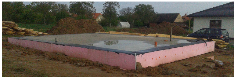
Obr. 6- Připravená základová konstrukce pro uložení patních trámů
