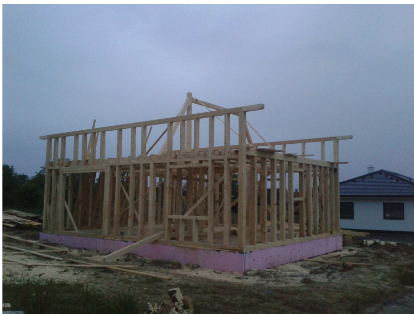
Obr. 9- Na tomto obrázku je již dokončena stavba přízemí a zároveň vytvořena první plná vazba pro konstrukci krovu
