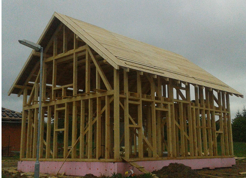
Obr. 11- Opláštění konstrukce krovu pomocí hoblovaných prken
