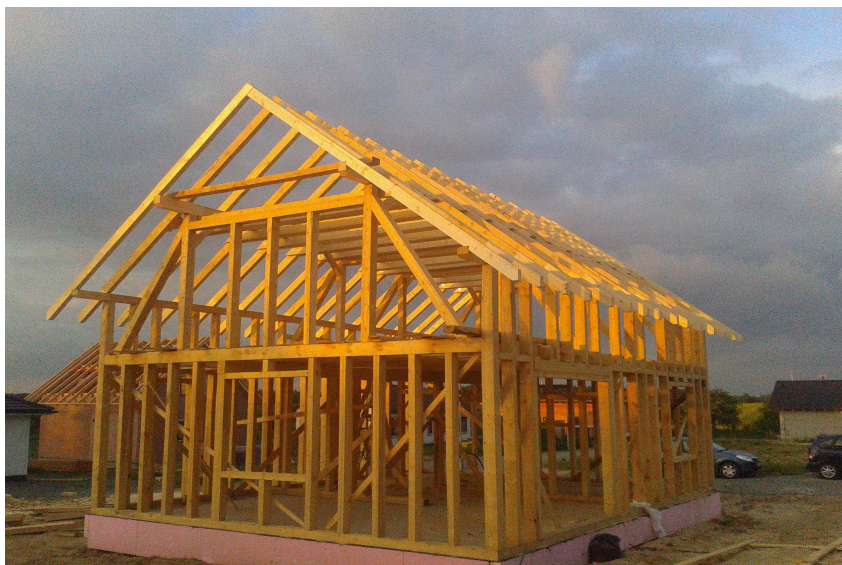
Obr.10- Dokončení nosné konstrukce dřevostavby
