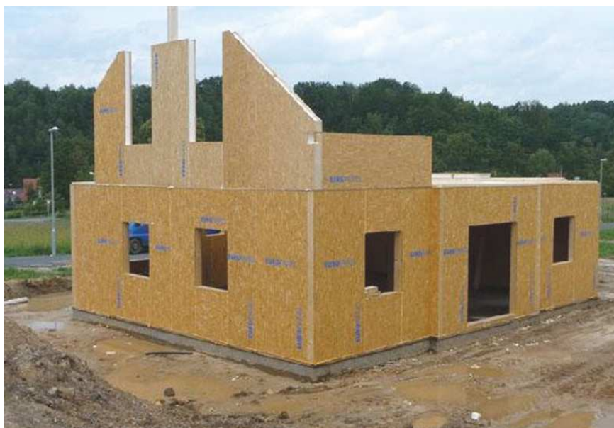
Obr. 5 – Vlastní foto realizace panelové dřevostavby
