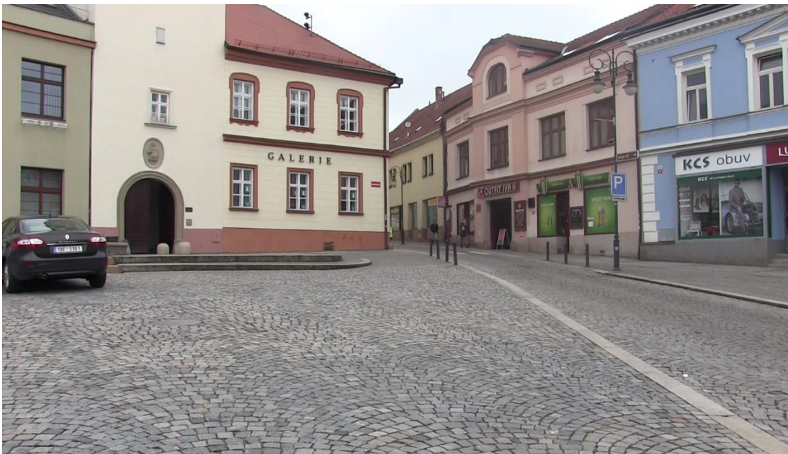
Obr. 107: Naváděcí dopravní značky na parkoviště na ulici Hradní
