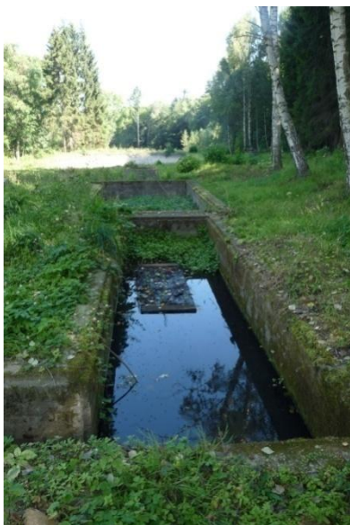
Obrázek 13 Betonové objekty, které byly v rámci revitalizace odstraněny (foto J. Koutný)
