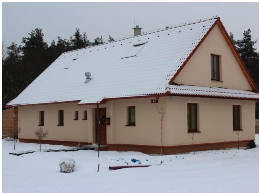
Obrázek 11 Objekt č. 3 - Novostavba Srbsko 3
