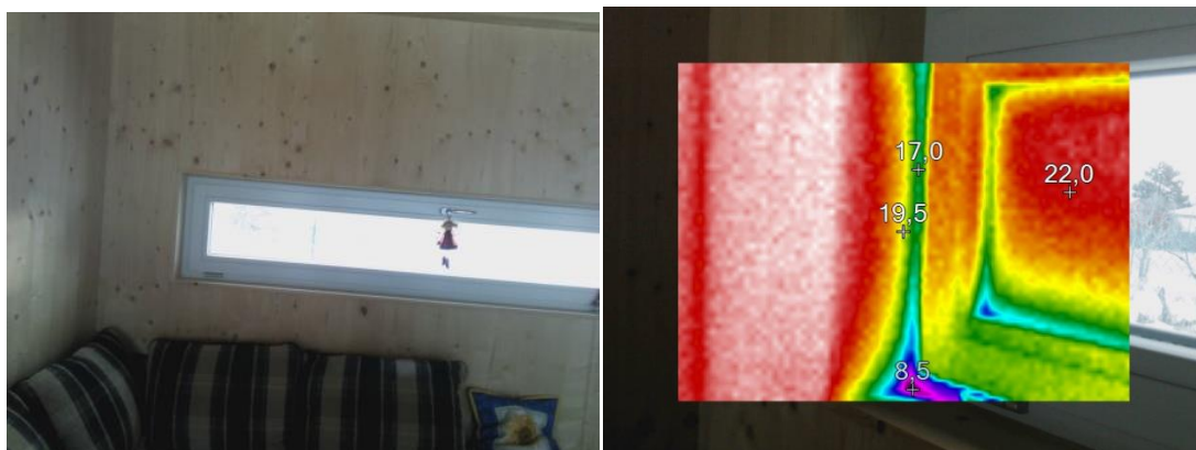
Obrázek 26 Objekt č. 6 – Výsledky měření okna- měření v interiéru
