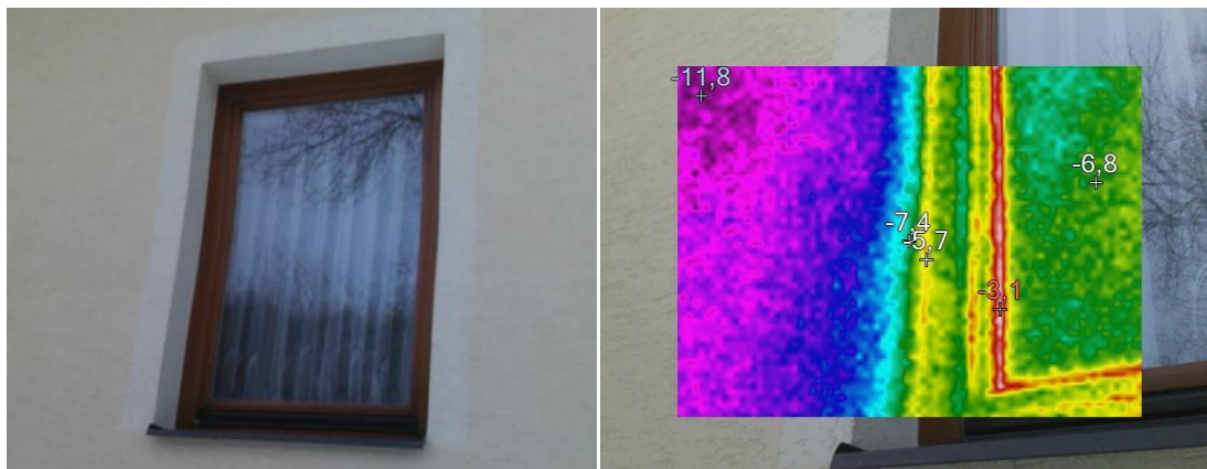
Obrázek 9 Objekt č. 2 – Výsledky měření okna- měření v exteriéru Zdroj: [vlastní zpracování]
