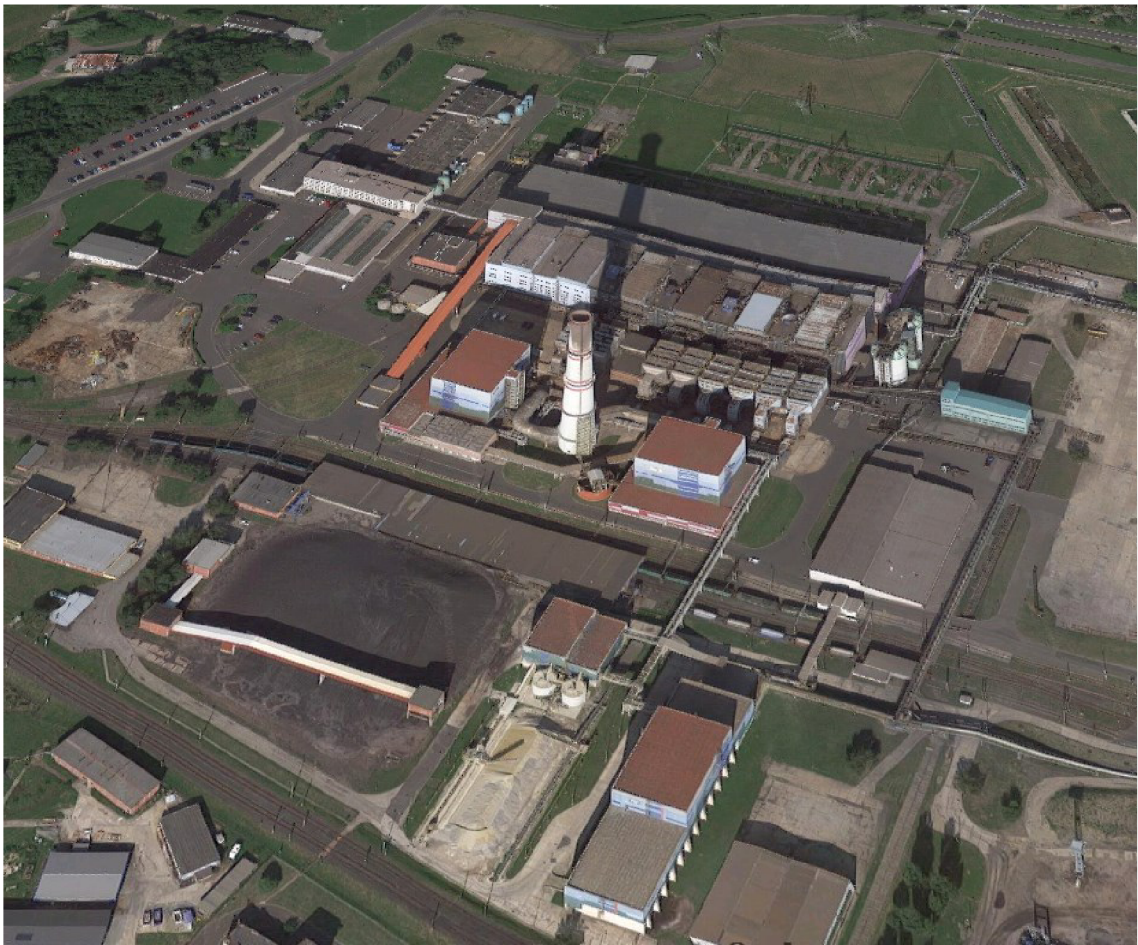
Obr. 2.4 – Satelitní snímek areálu elektrárny Prunéřov I
