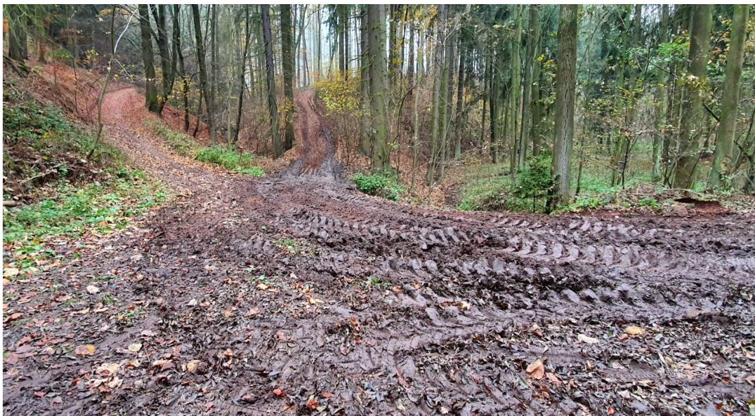
Obrázek č. 42: Erozní podmáčené rýhy na 3L při přibližování v polozávěsu (autor)
