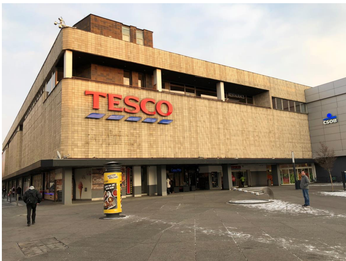
Obr. 5: Fotodokumentace OD Tesco – současný stav (Zdroj: vlastní zpracování, 2019)
