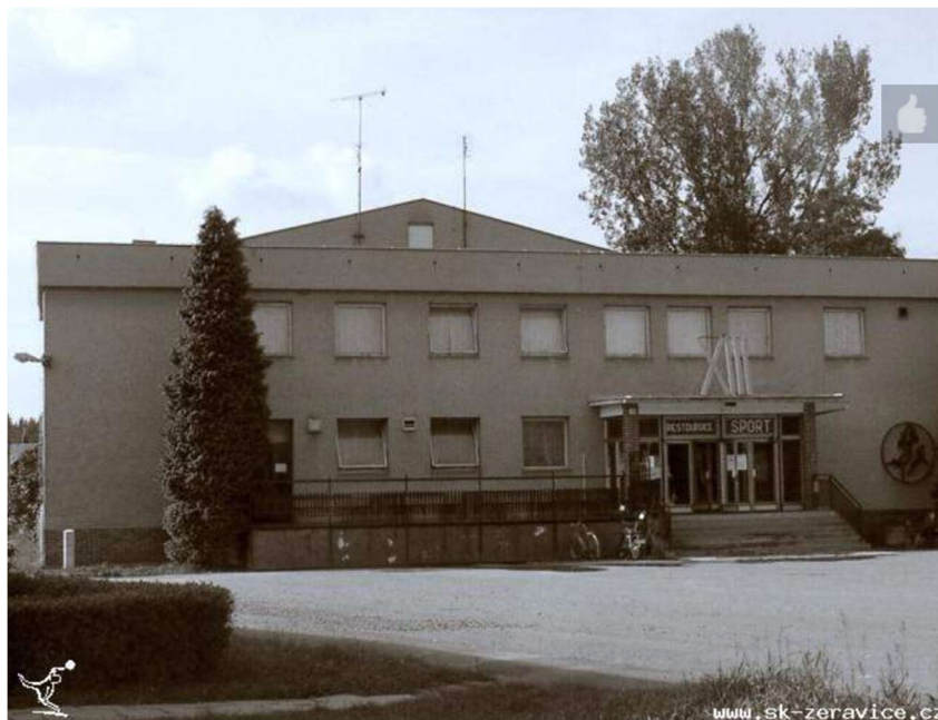
Obrázek 6. Sportovní hala v Žeravicích
