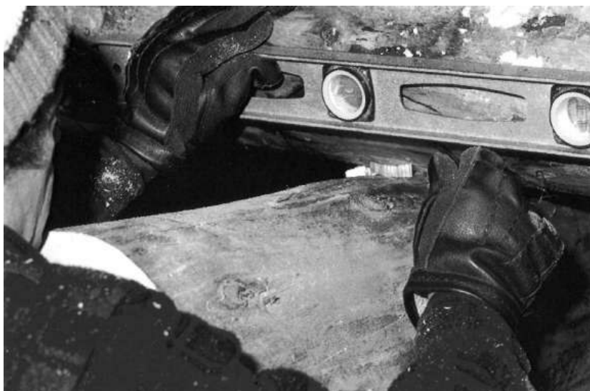
Obr. 4.11 Určení vodorovné roviny [8]
