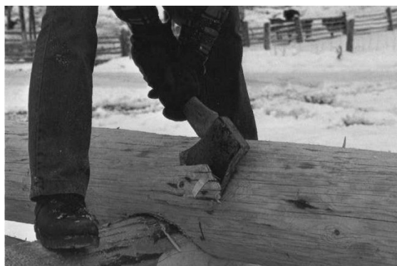
Obr. 3.11 Provedení záseku [8]
