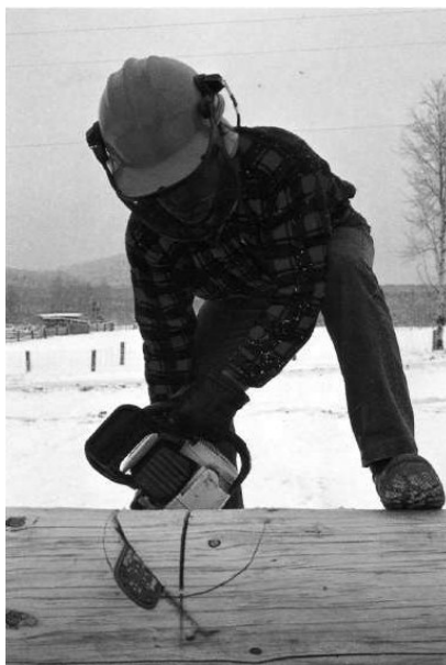
Obr. 3.10 Započetí řezu u spojů [8]
