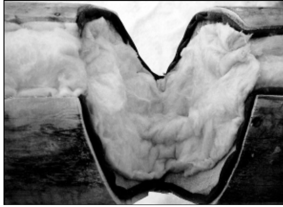
Obr. 3.18 Izolace drážek a spojů [5]
