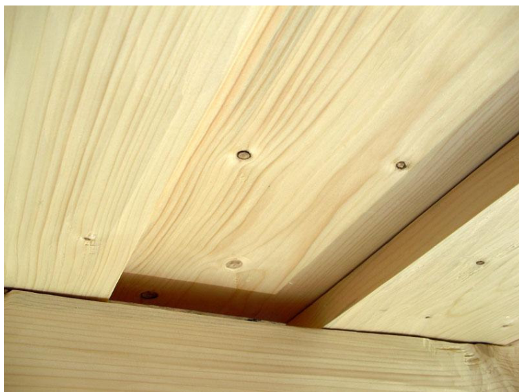
Obr. 4.17 Provedený záklop [14]
