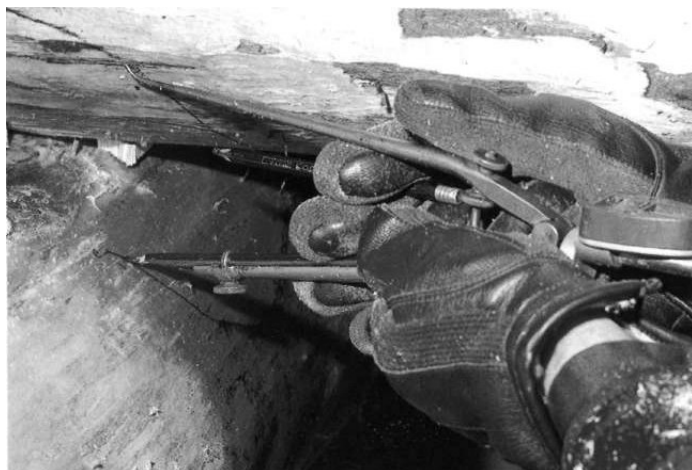
Obr. 4.12 Značení okraje řezu [8]
