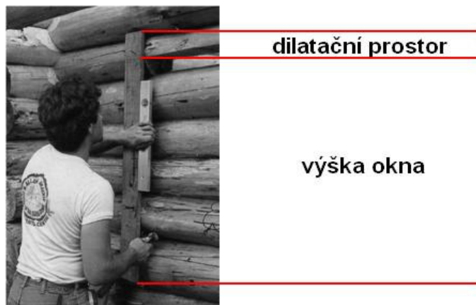
Obr. 3.19 Rozměření okna [8]
