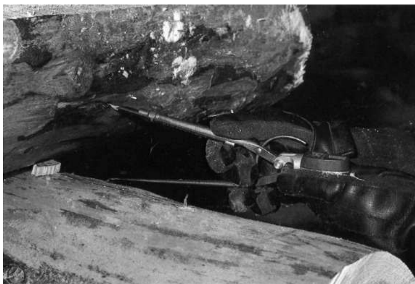
Obr. 4.9 Práce se srubařským kružítkem [8]
