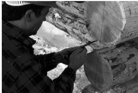
Obr. 3.13 Odměření drážky [8]
